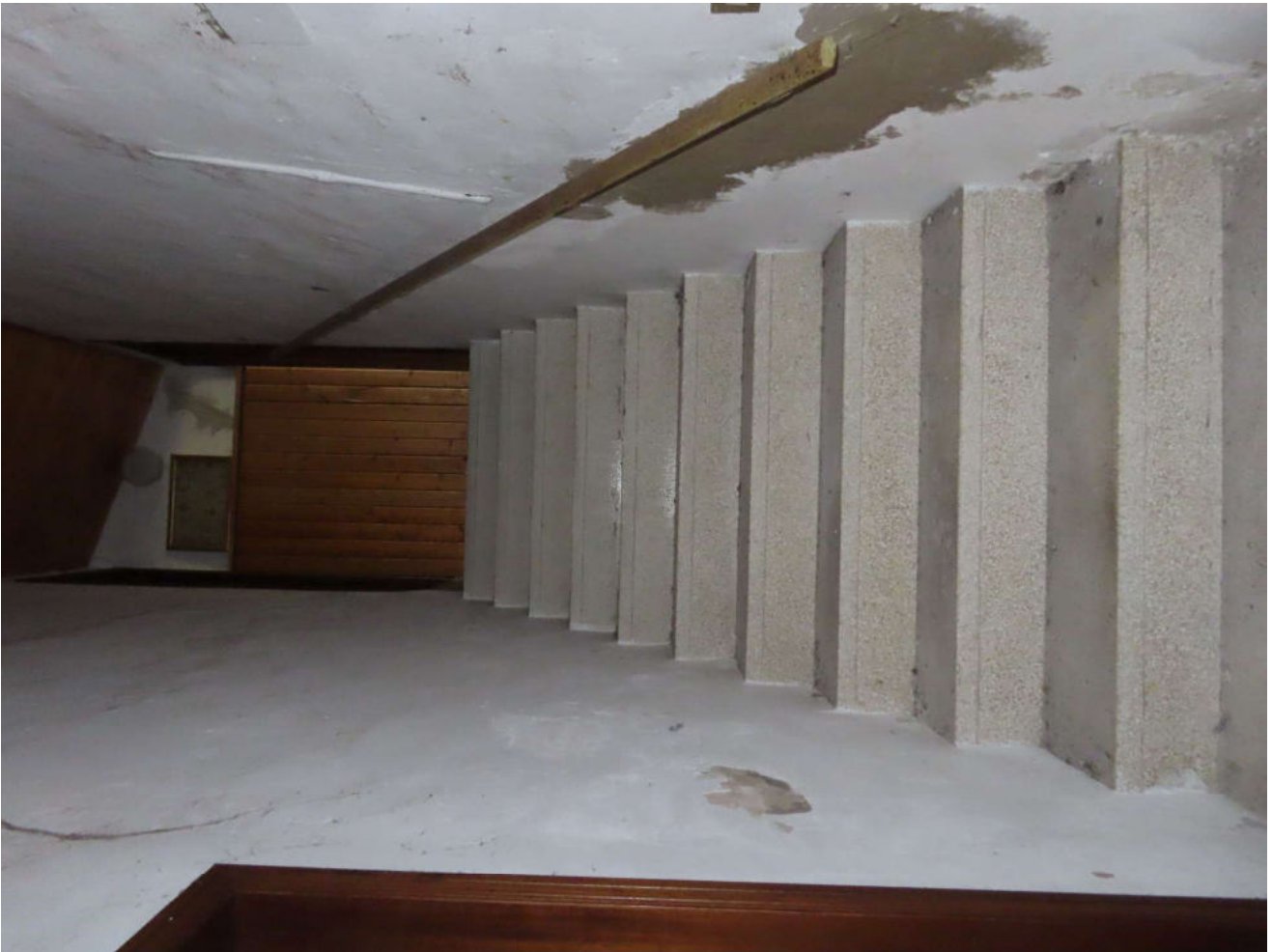
SCALA ACCESSO PIANO PRIMO
