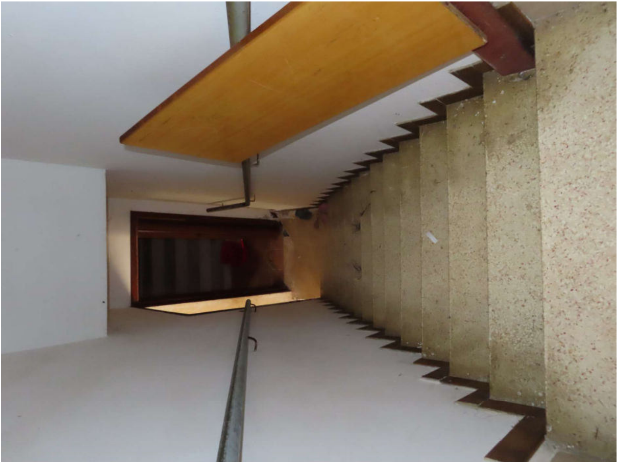
SCALA ACCESSO PIANO PRIMO
