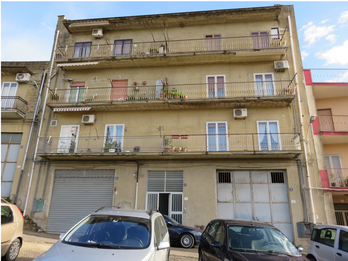
Foto 1 - Prospetto Via San Vincenzo de Paoli ( Via Luisa Marilac)
