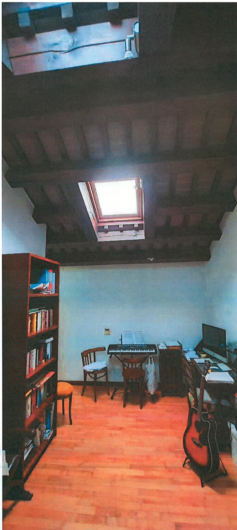
Zona Sottotetto - 1 (abusivo)
