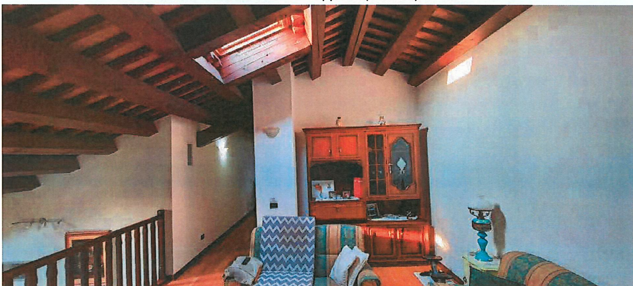
Sottotetto – 3 Soppalco (abusivo)
