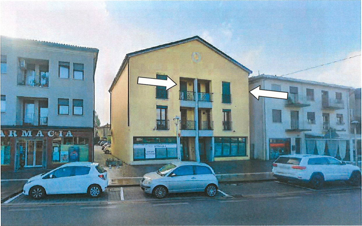
Vista dell'immobile con indicata la posizione dell'appartamento
