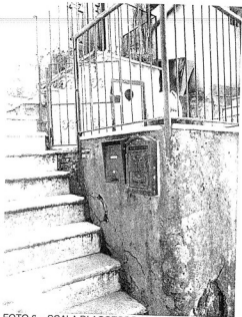
FOTO 6 - SCALA DI ACCESSO AL PIANO 1°
