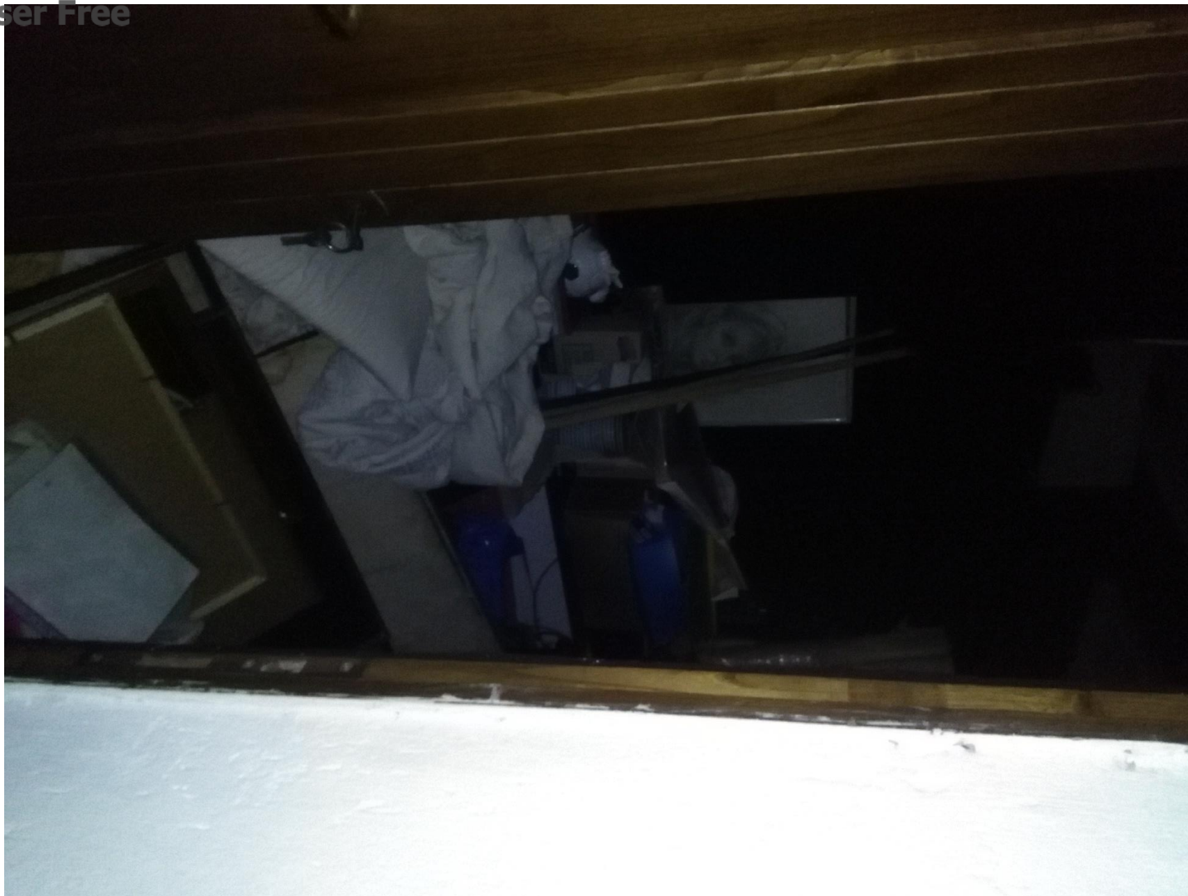
Punto di vista fotografico – Vano 8
