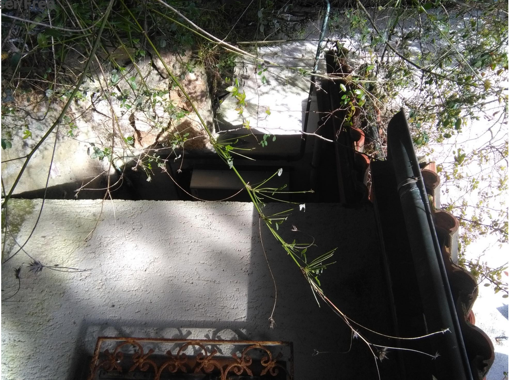
Punto di vista fotografico – Vano 12
