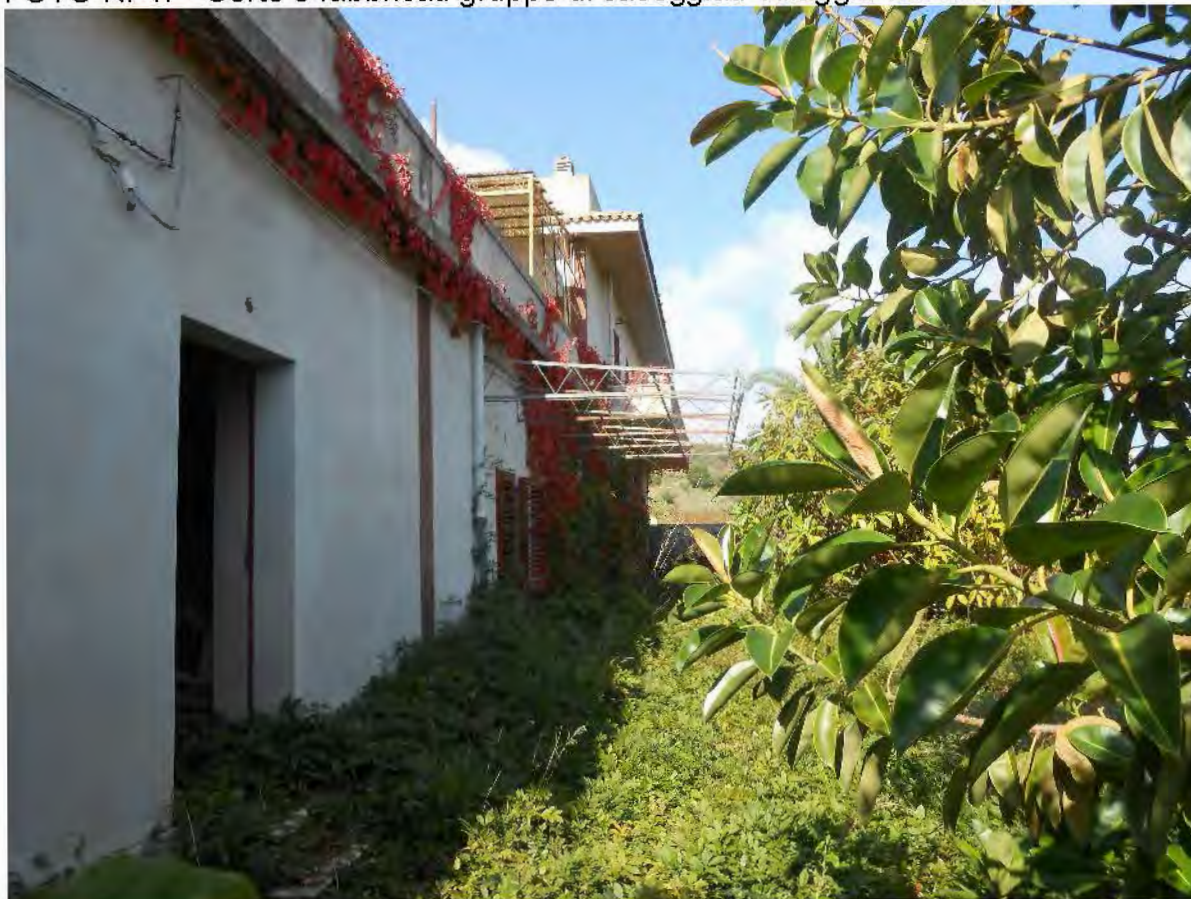
FOTO N. 47 –Corte e fabbricati gruppo di caseggiati Villaggio Curcuraci
