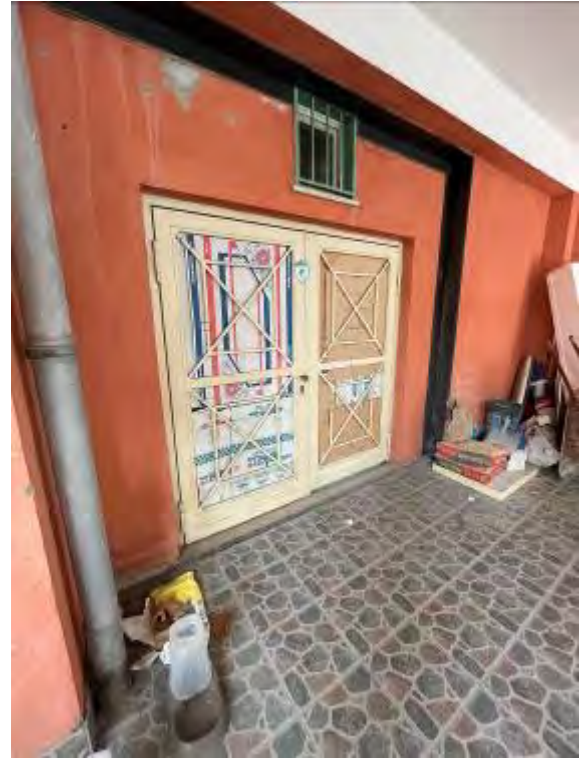
Fotografia n. 4 _ Ingresso al sub 36
