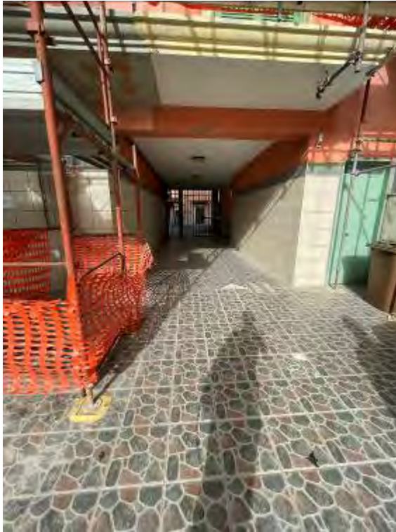
Fotografia n. 3 _ Androne di ingresso
