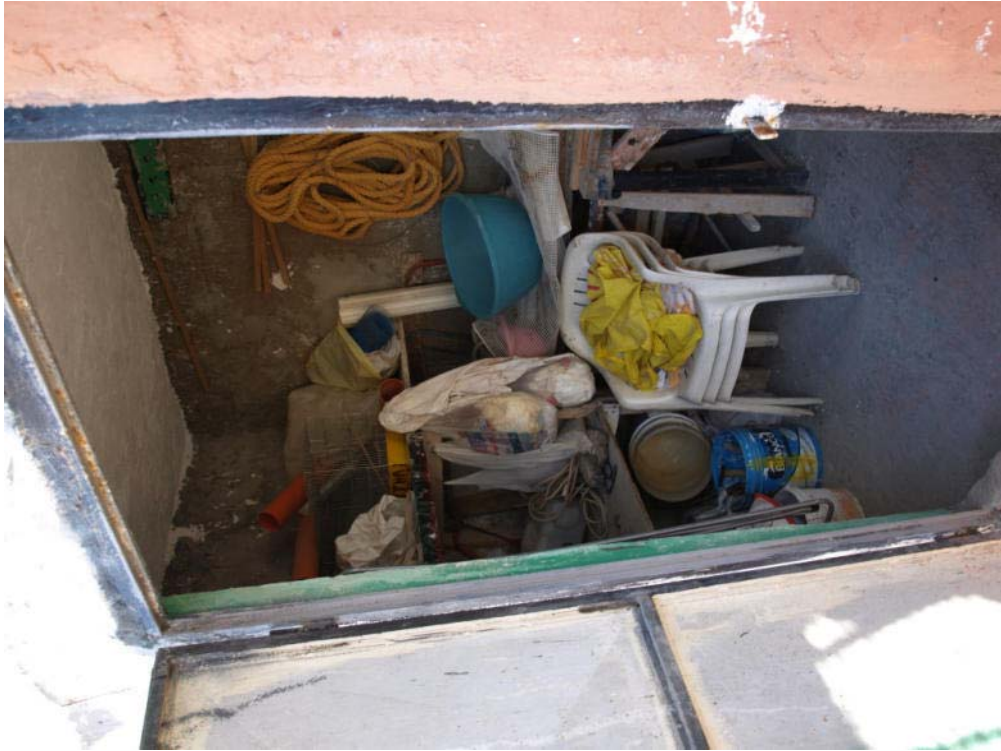
Foto n° 27 – Appartamento per civile abitazione sito in Gela con ingresso dalla via Francesco Petrarca n° 72, primo, secondo e terzo piano – Foglio 187 part. 454 sub 8 – Panoramica del lastrico solare con il piccolo vano a sud.
