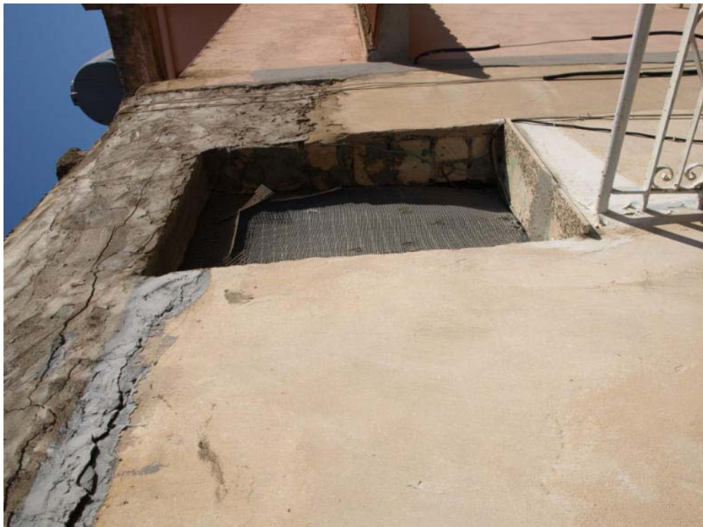
Foto n° 28 – Appartamento per civile abitazione sito in Gela con ingresso dalla via Francesco Petrarca n° 72, primo, secondo e terzo piano – Foglio 187 part. 454 sub 8 – – Panoramica del lastrico solare con il prospetto sud.
