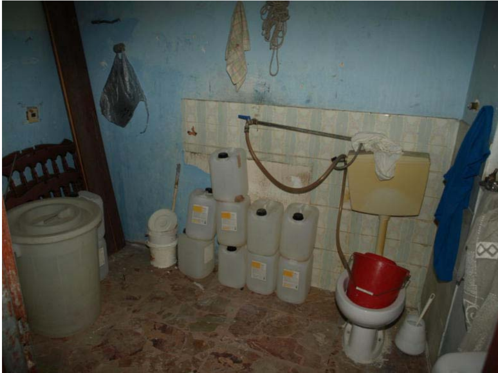
Foto n° 11 – Appartamento per civile abitazione sito in Gela con ingresso dalla via Francesco Petrarca n° 72, primo, secondo e terzo piano – Foglio 187 part. 454 sub 8 – Panoramica degli interni del primo piano.
