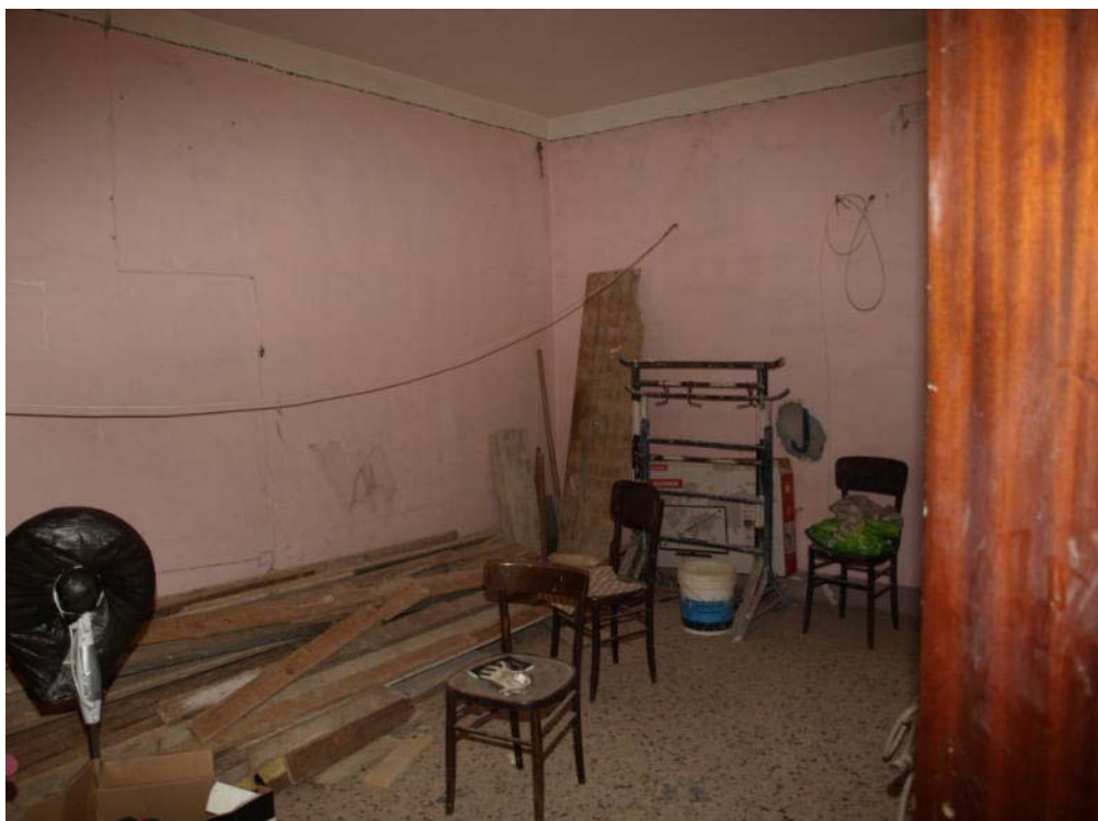
Foto n° 7 – Appartamento per civile abitazione sito in Gela con ingresso dalla via Francesco Petrarca n° 72, primo, secondo e terzo piano – Foglio 187 part. 454 sub 8 – Panoramica degli interni del primo piano.
