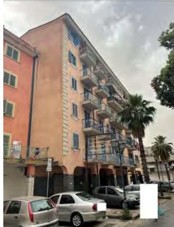
Fotografia n. 2 _ Particolare prospetto su via Matteotti
