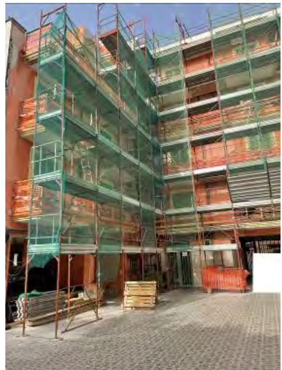
Fotografia n. 2 _ Prospetto del fabbricato sulla corte
