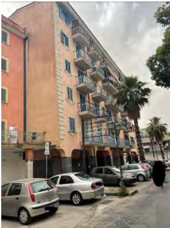
Fotografia n. 1 _ Prospetto su via Matteotti
