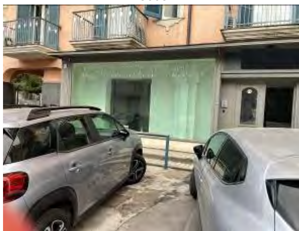
Fotografia n. 3 _ Ingresso e vetrine su via Nicola Rocco
