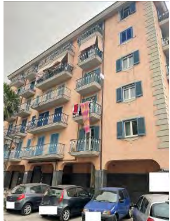
Fotografia n. 2 _ Prospetto su via Matteotti
