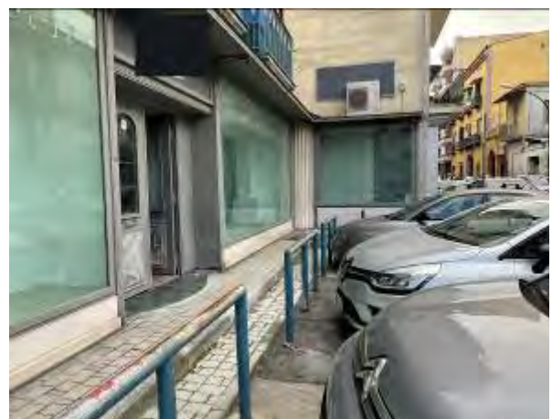
Fotografia n. 4 _ Ingresso e vetrine su via Nicola Rocco
