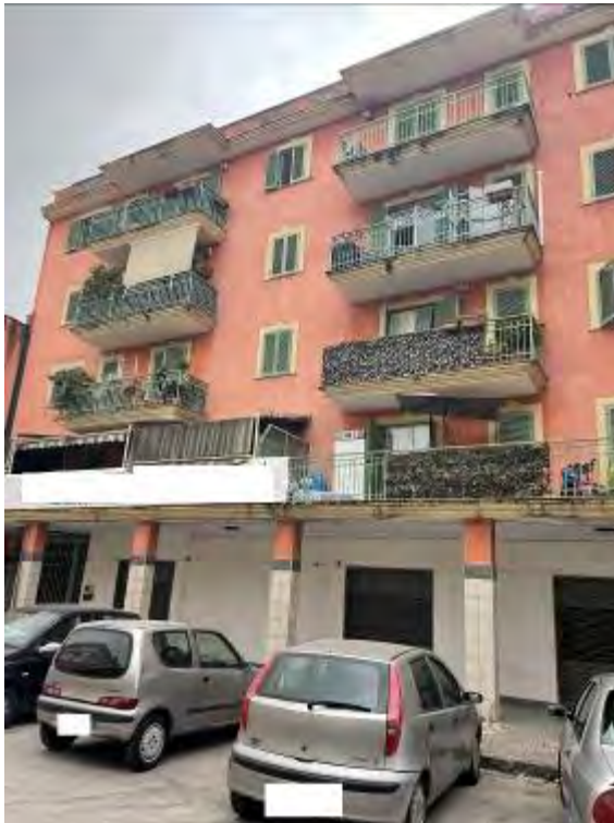
Fotografia n. 1 _ Prospetto su via Matteotti
