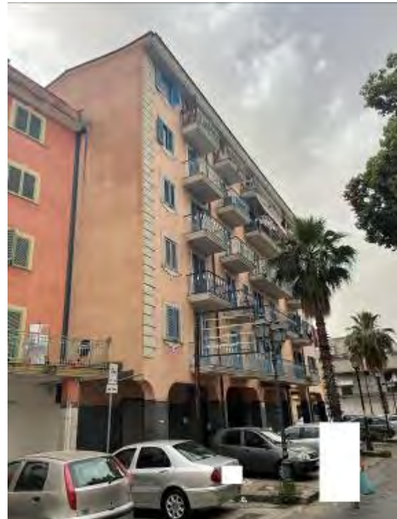
Fotografia n. 2 _ Particolare prospetto su via Matteotti
