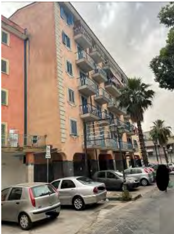
Fotografia n. 1 _ Prospetto su via Matteotti
