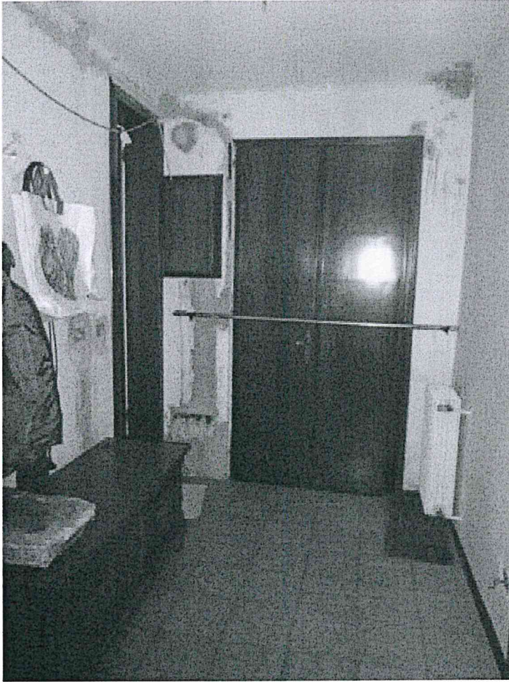
Foto 28: disimpegno/ingresso piano terra
