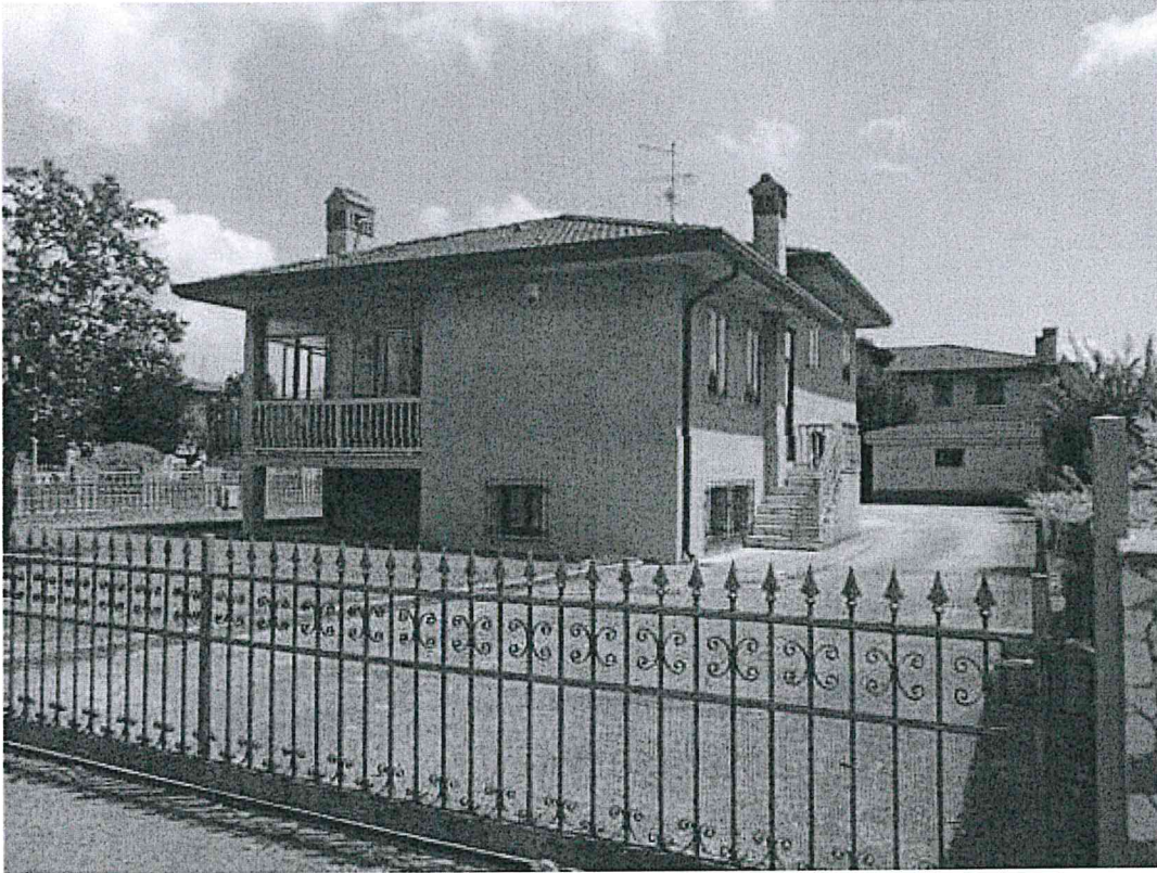
Foto 9: prospetto ovest e sud, da via De Gasperi
