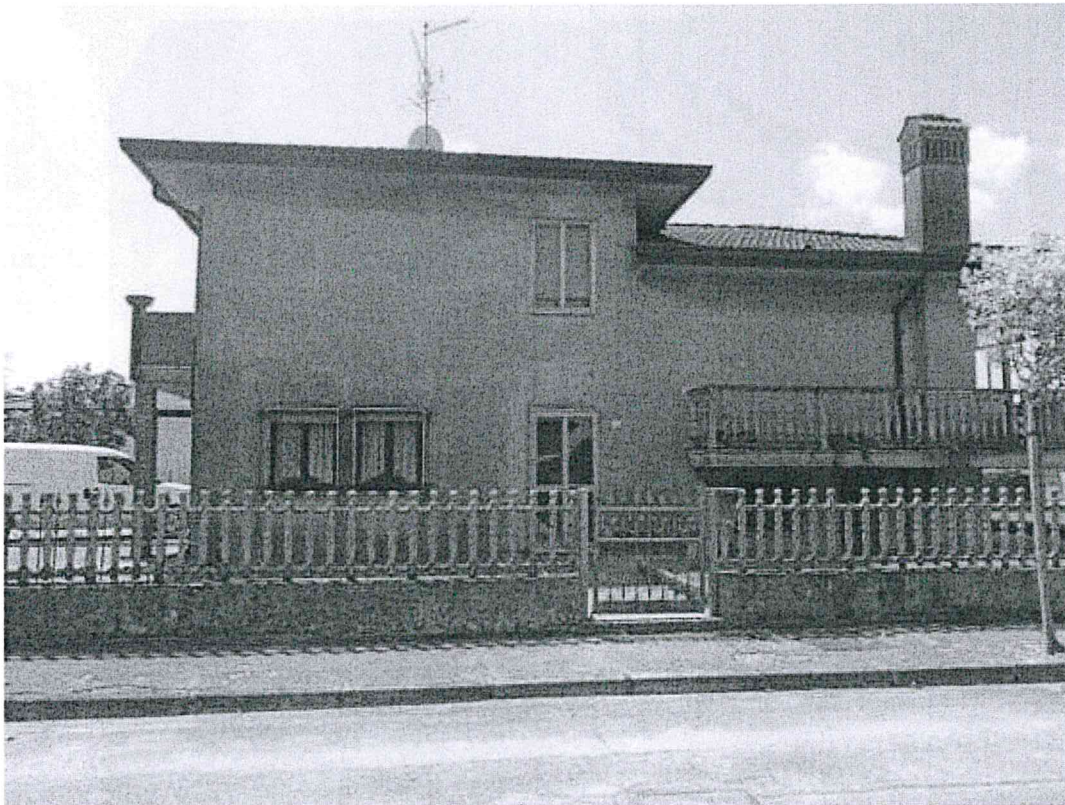
Foto 5: facciata principale nord dell'abitazione, da via Mingoni
