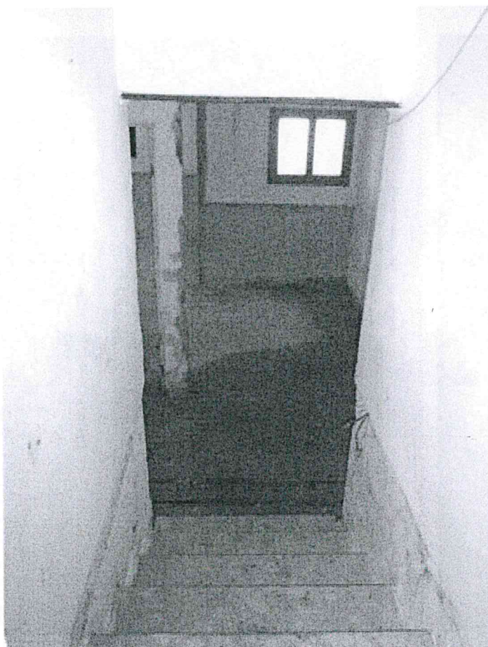
Foto 32: scala dal piano terra verso il piano semi-interrato
