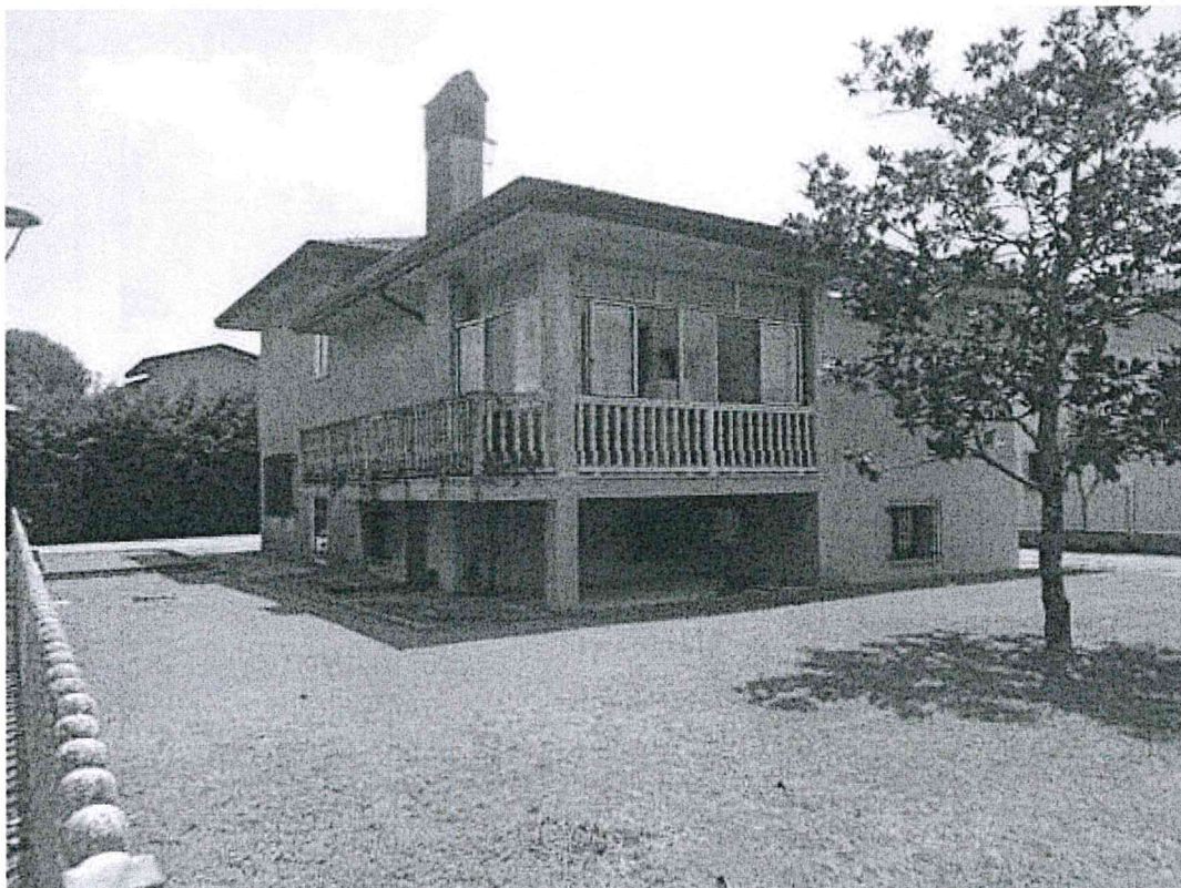
Foto 6: prospetti nord ed ovest dell'abitazione, cortile pertinenziale
