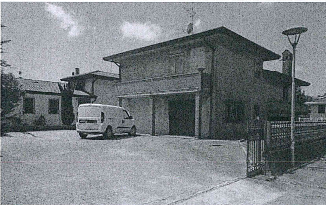
Foto 2: Abitazione vista da via Mingoni, prospetti nord ed est
