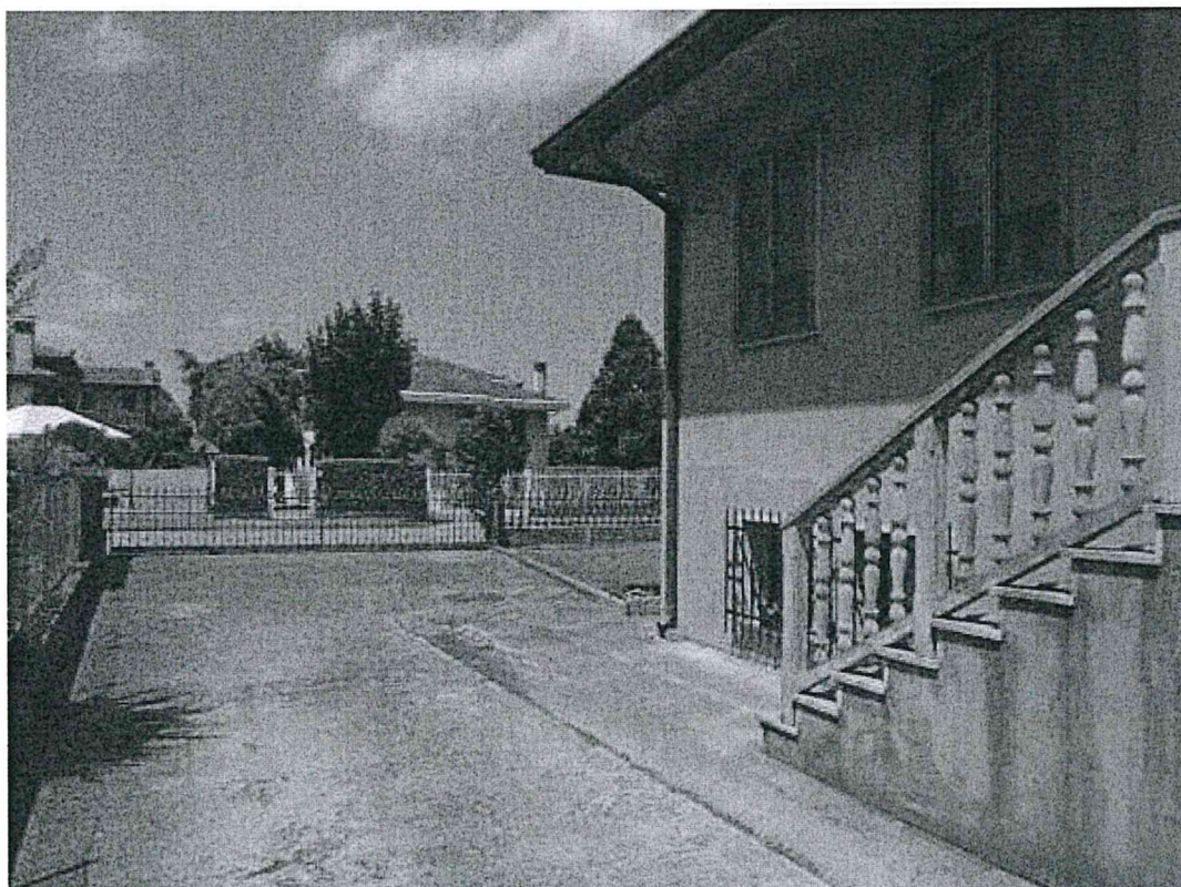
Foto 12: prospetto sud e cancello verso via De Gasperi
