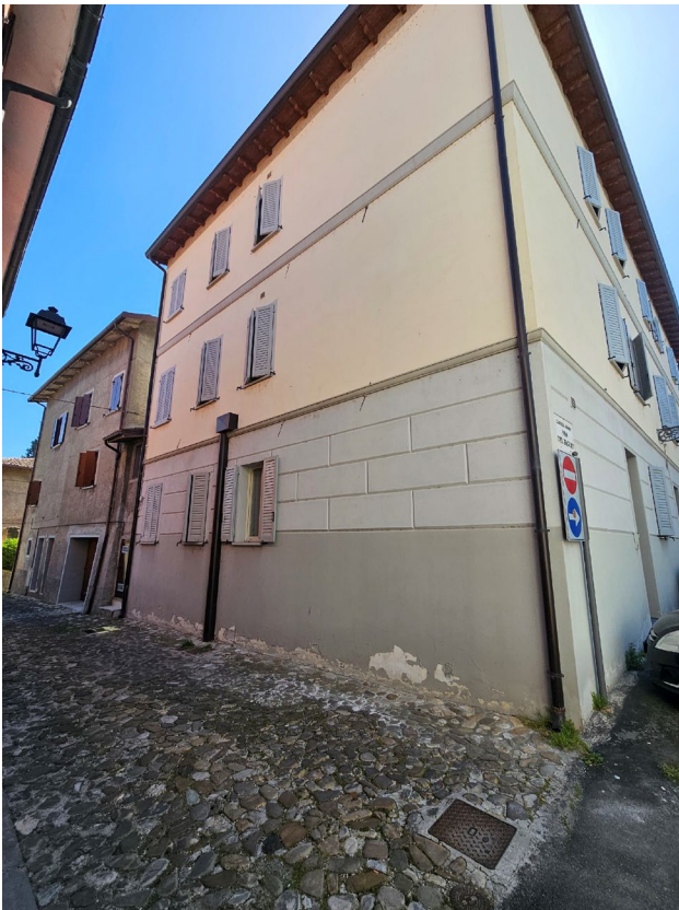
Esterno 2: Prospetto nord su via Migliorini
