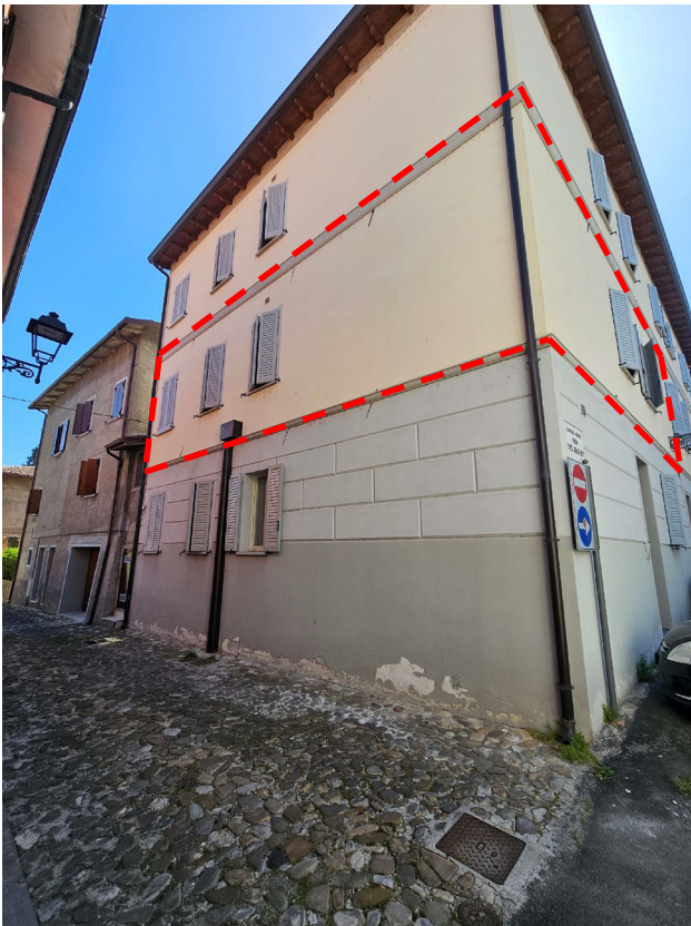
Esterno 2: Prospetto nord su via Migliorini
