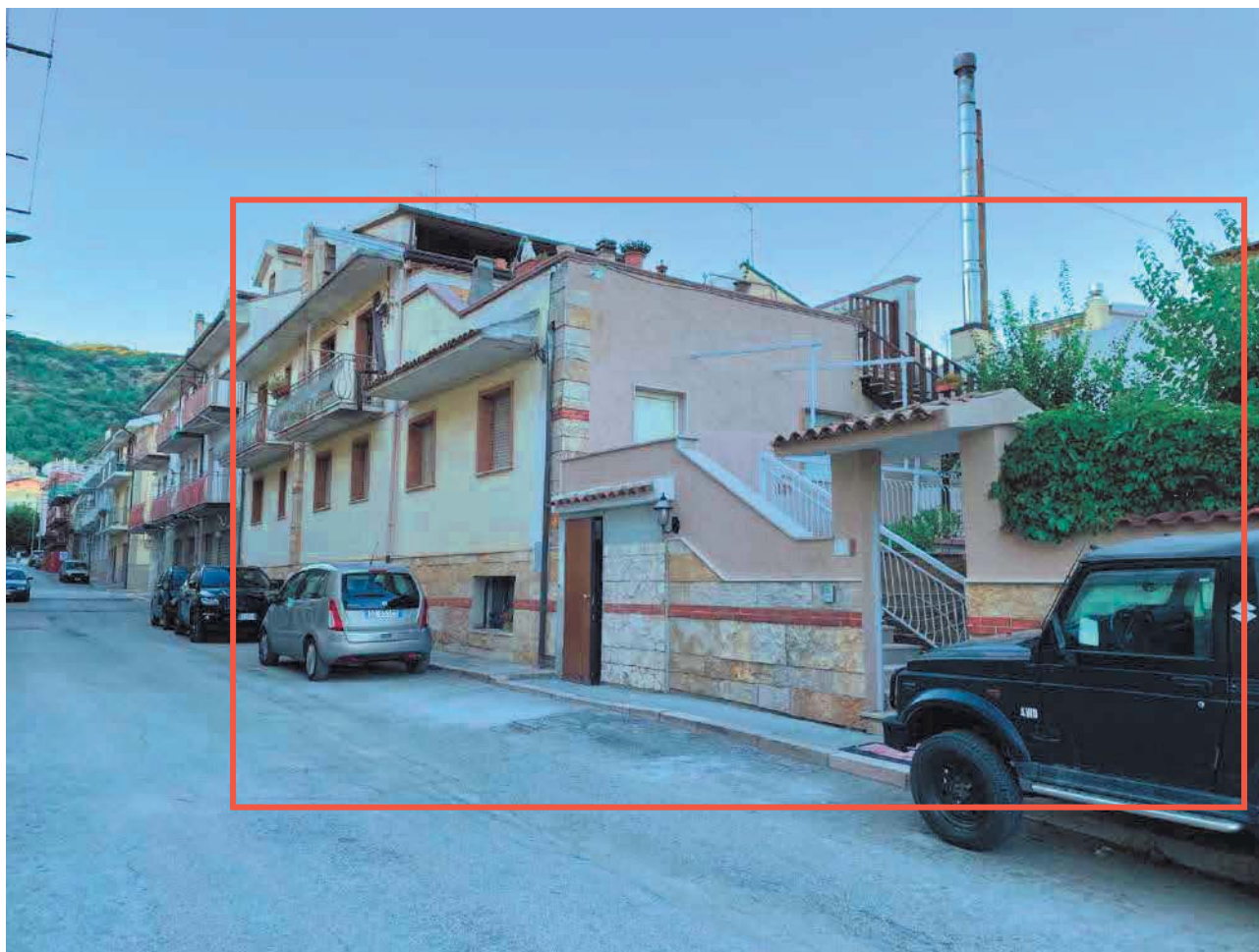
Figura 3. LOTTO UNICO: Fabbricato in cui si trovano gli immobili pignorati al F. 57, P.IIa 2660, Sub. 1-2-3-4-5 ubicati in San Giovanni Rotondo alla Via E. Mandes n. 25 e 27.
