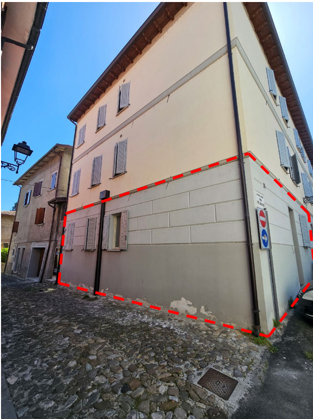
Esterno 2: Prospetto nord su via Migliorini
