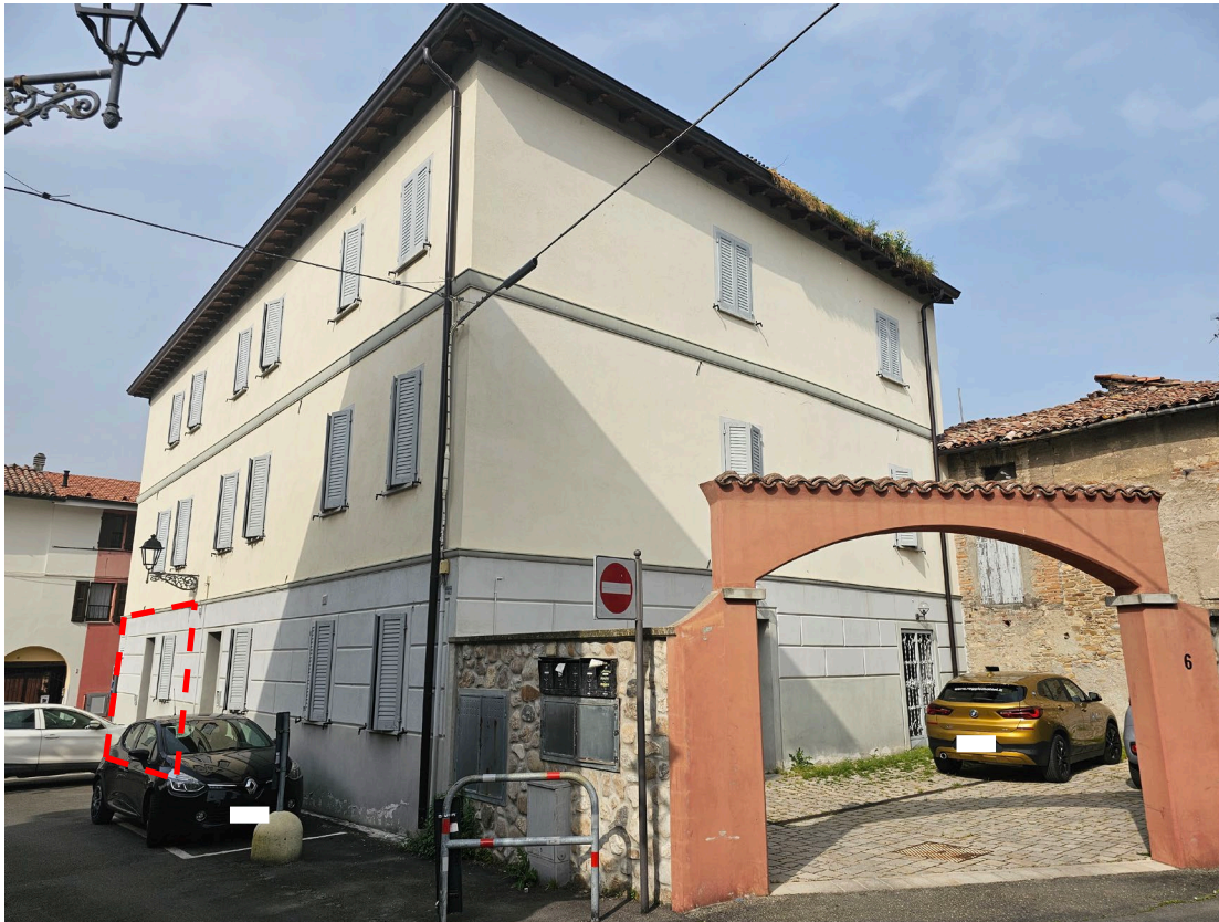
Esterno 4: Vista di insieme – Prospetti sud-ovest – fronti su via del Taglio angolo via San Biagio
