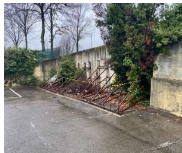
Vista puntelli in area Condominiale
