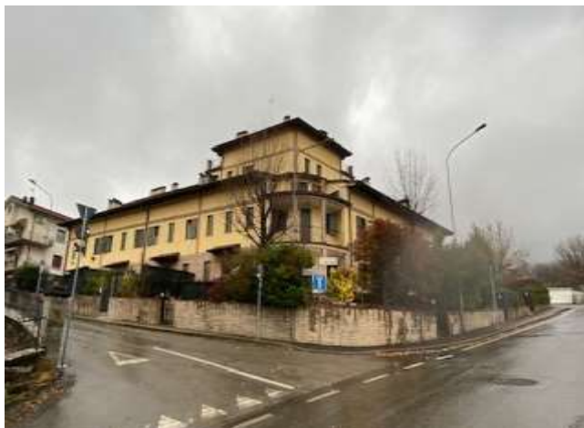
Vista Esterna n.2
