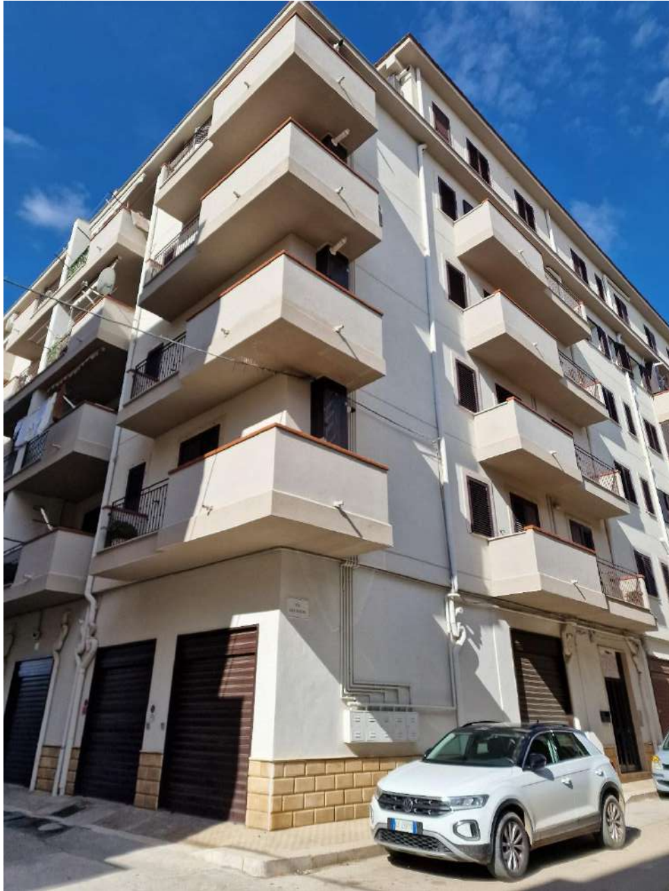
Angolo nord-est dell'edificio
