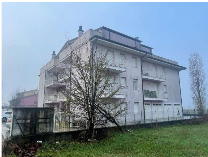
Ripresa fotografica esterna fronte Sud
