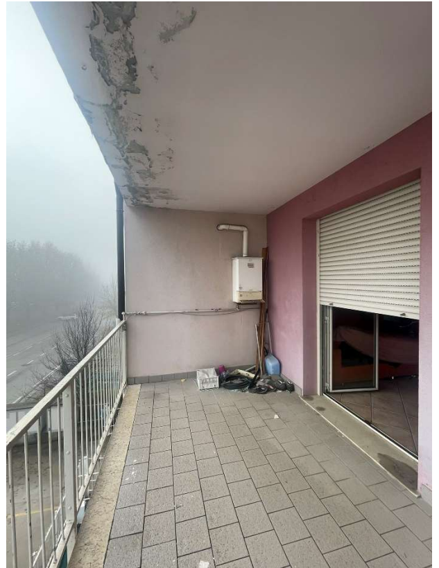
Balcone fronte strada lato EST
