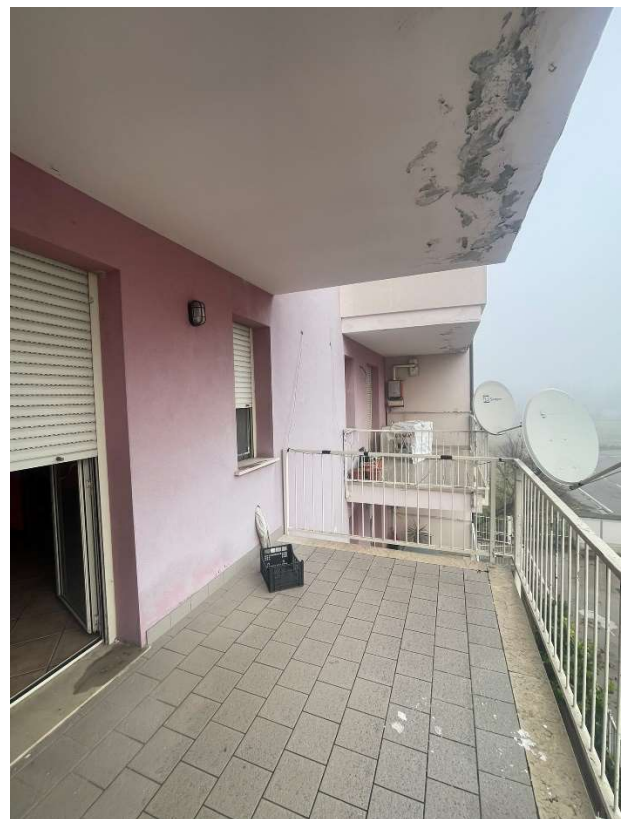
Balcone fronte strada lato EST
