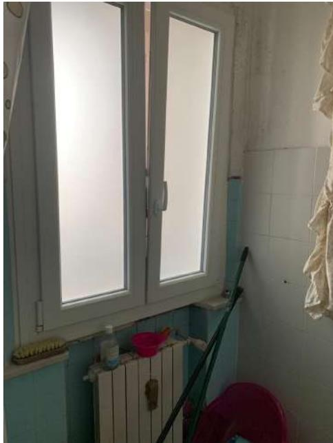
particolare elemento radiante con valvola termostatica bagno
