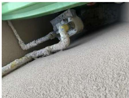
particolare radiatore in ghisa con valvola termostatica
