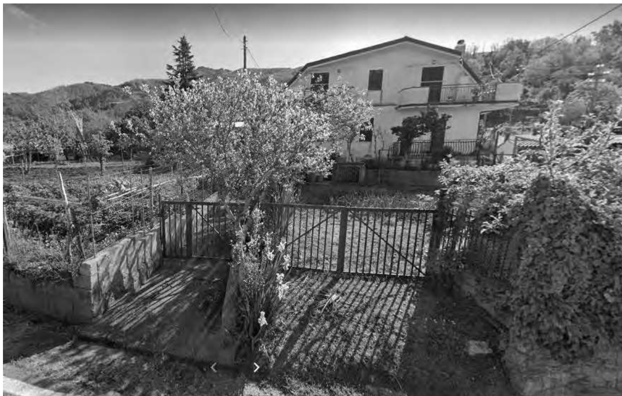
Vista dalla strada provinciale da ovest
