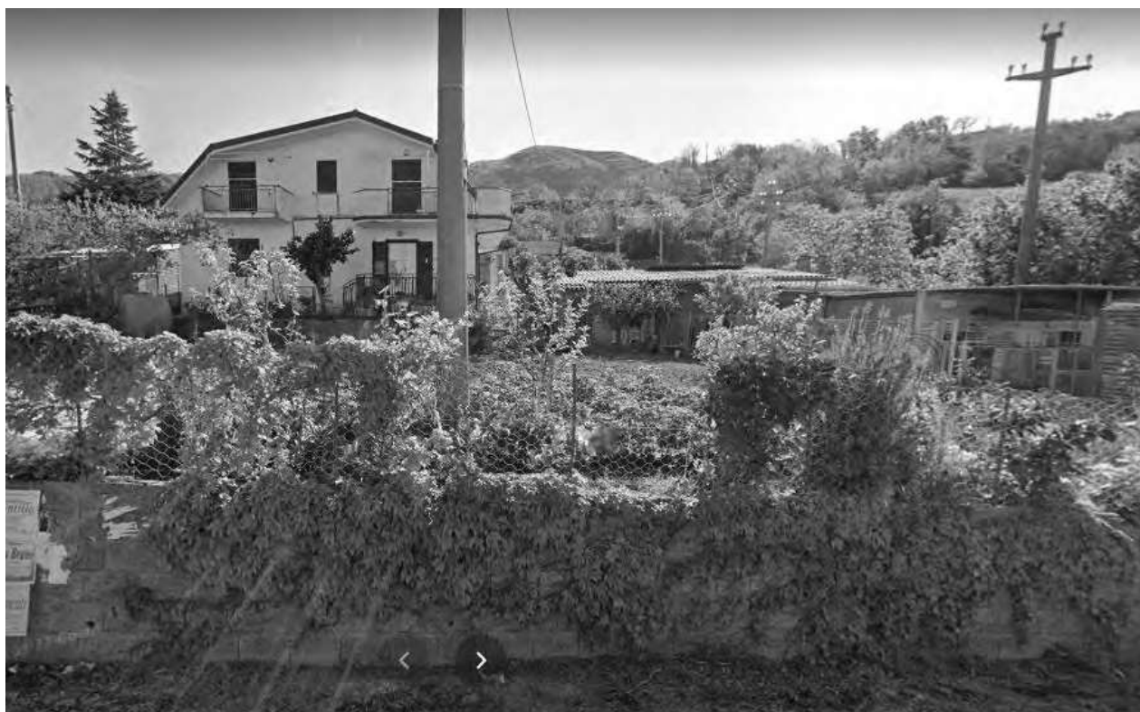
Vista dalla strada Provinciale da ovest
