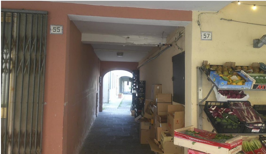
Figura 19: Passaggio coperto condominiale (mapp220) che consente di mettere in comunicazione cantine e posti auto con alcuni locali (appartamenti e cantine) oggetto di pignoramento
