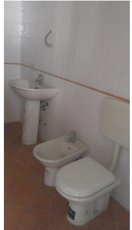
Figura 25: Bagno posto al primo piano
