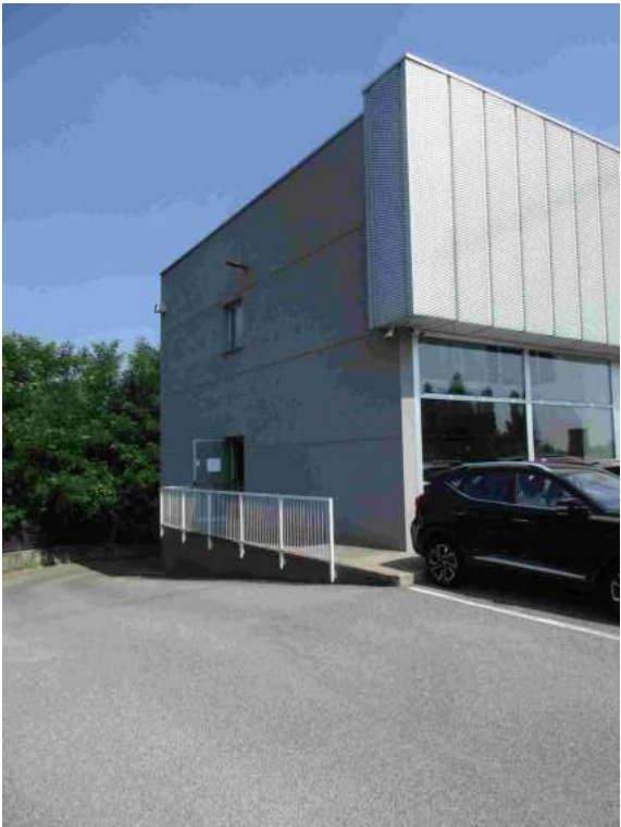
FOTOGRAFIA N. 8 - Vista da piazzale interno
