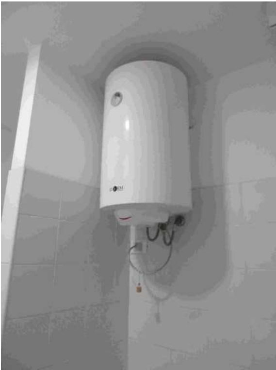
FOTOGRAFIA N. 42 - Scaldacqua elettrico
