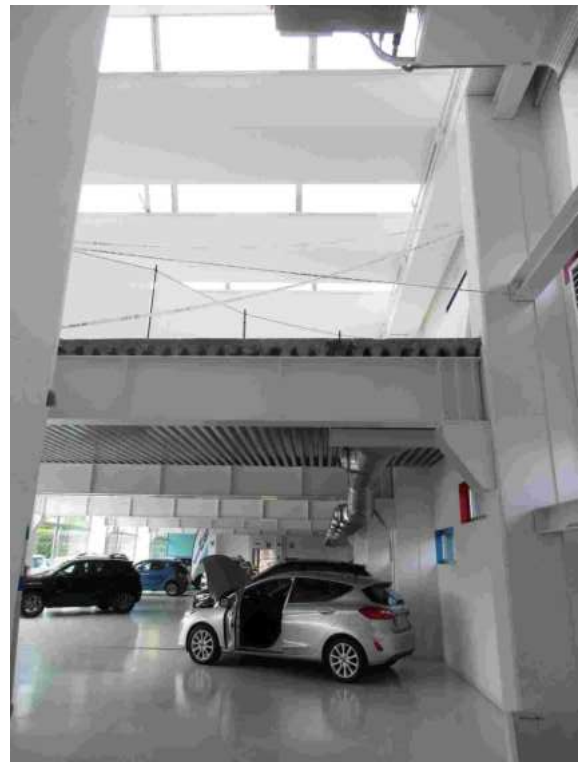
FOTOGRAFIA N. 12 - Vano elevatore auto
