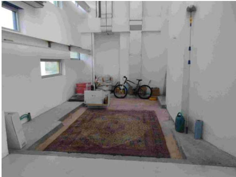
FOTOGRAFIA N. 13 - Vano elevatore auto
