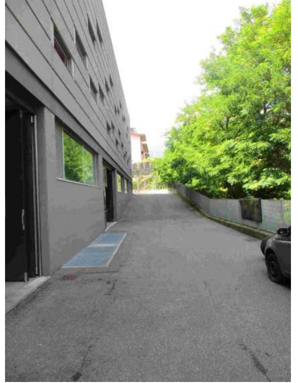
FOTOGRAFIA N. 30 - Corsello di manovra
