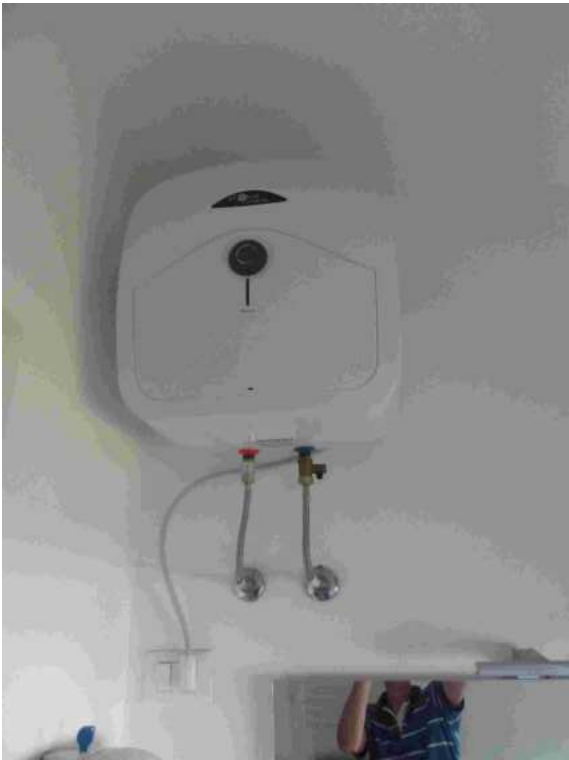
FOTOGRAFIA N. 19 - Scaldacqua elettrico
