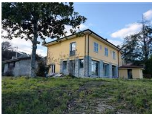
vista dei prospetti lati sud est e nord est del fabbricato residenziale oggetto di E.I. (dist. Cat. Fg. 16 mapp. 274); sul davanti (P.T.) il porticato che è stato tamponato; sulla sinistra il manufatto privo di titolo
