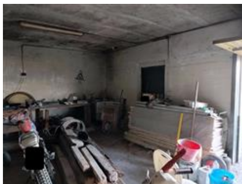
INTERNO – LOCALE DEPOSITO ATTREZZI (dist. Cat. Fg. 16 mapp.456) – piano terreno - vista interna del Locale Deposito Attrezzi seminterrato
