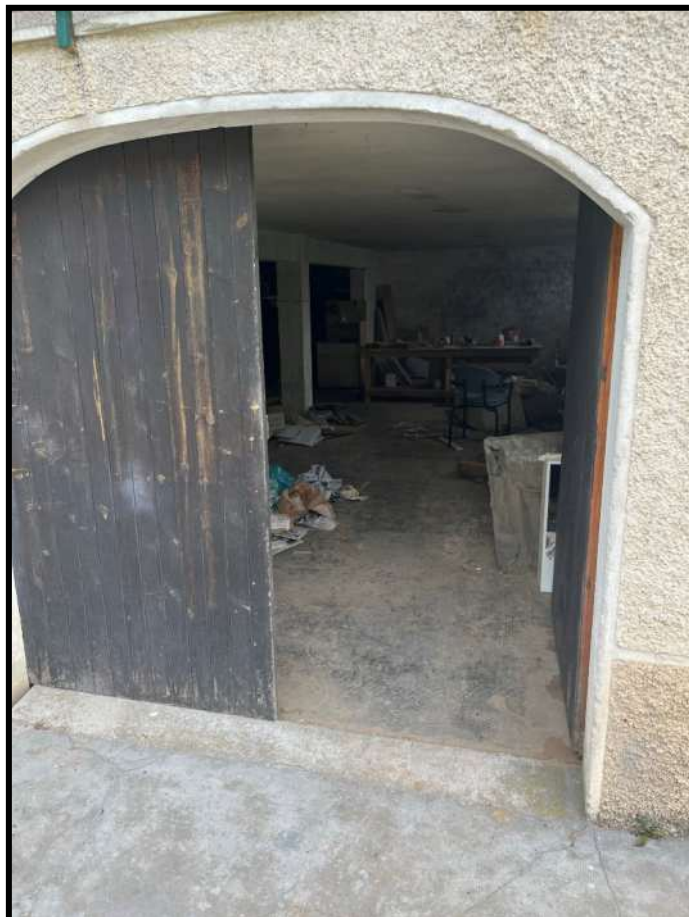
Foto 28 – Particolare ingresso box auto accessorio Corpo B
