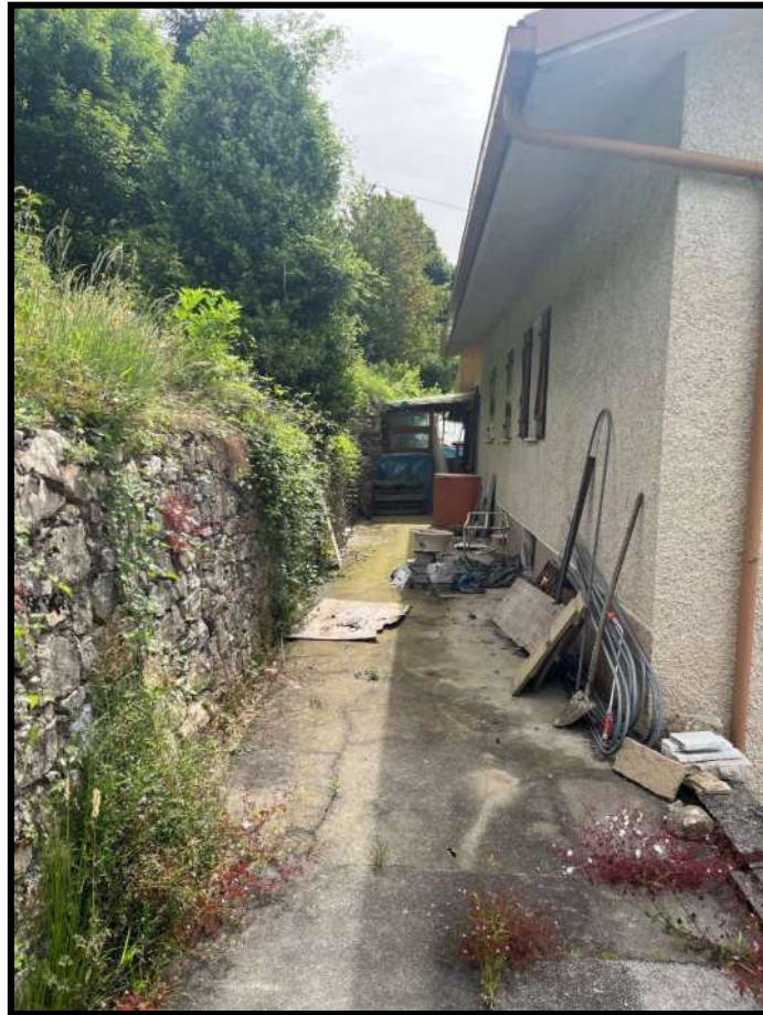
Foto 31 – Panoramica terreno residuo dalla costruzione posto a monte del Corpo A comune alle unità Corpo A e B
