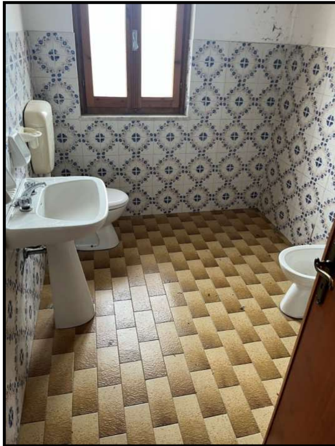
Foto 23 – Particolare w.c. piano primo appartamento Corpo B
