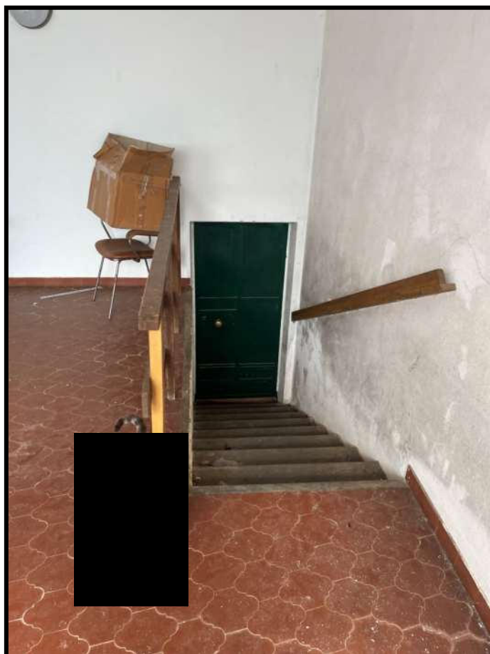
Foto 26 – Scala di collegamento tra il portico comune e il box auto accessorio Corpo B
