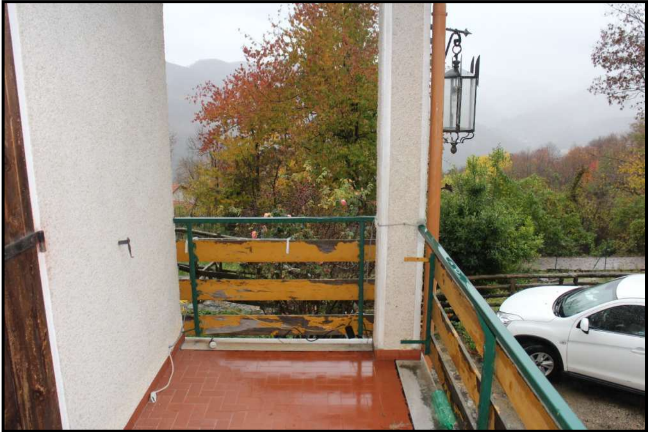
Foto 11 – Particolare balcone appartamento Corpo A
