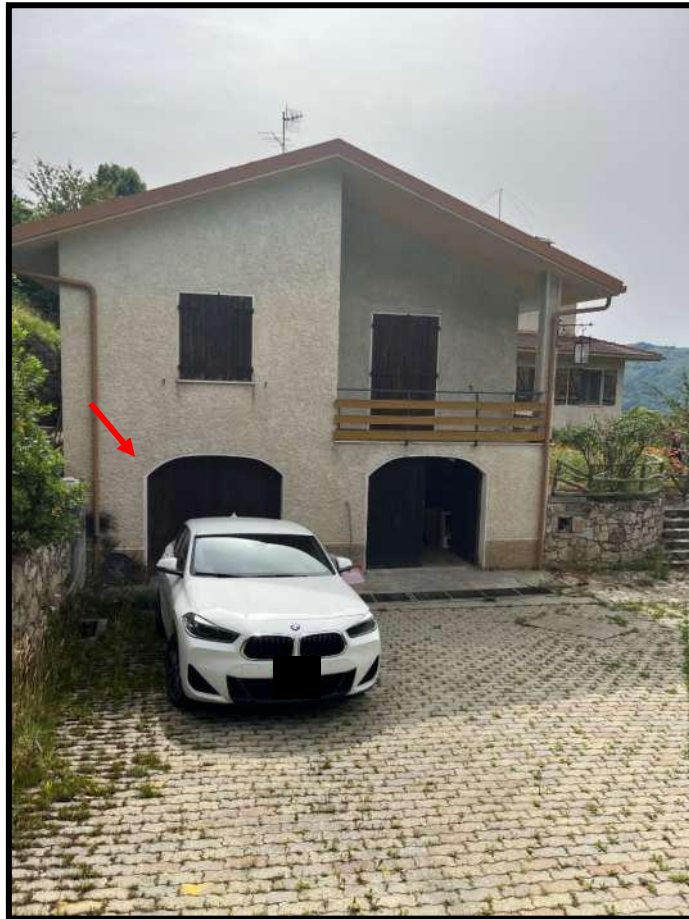
Foto 27 – Panoramica accesso box auto accessorio Corpo B
