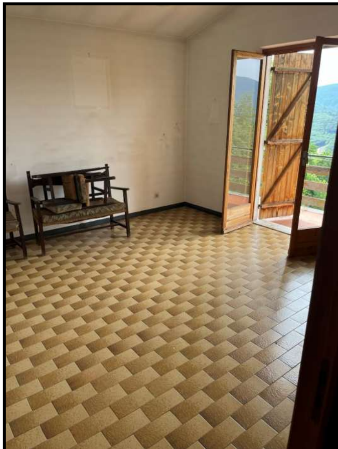
Foto 24 – Particolare camera piano primo appartamento Corpo B
