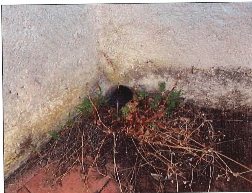
Dettaglio del foro per il deflusso delle acque piovane dal terrazzo
