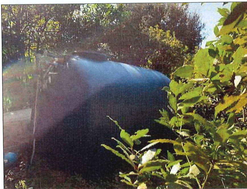
Dettaglio degli impianti
