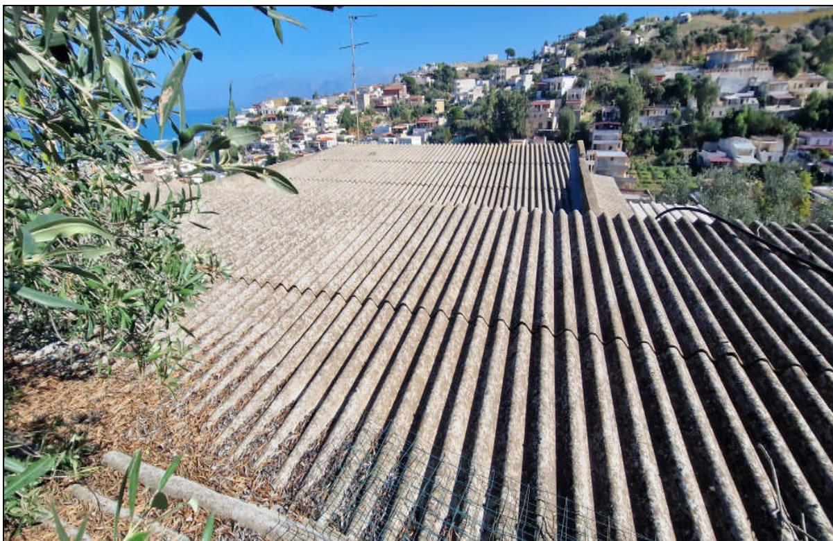
*Foto 26: Particolare copertura fabbricato via dei Papaveri C.da Canalotto - Alcamo.*
