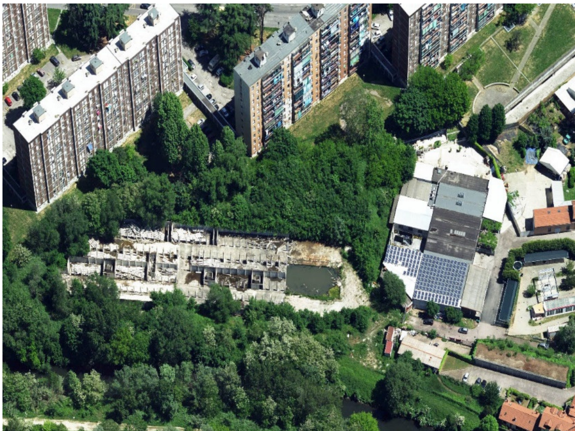
Foto 02 - Vista aerea dell'area urbana in corso di costruzione
