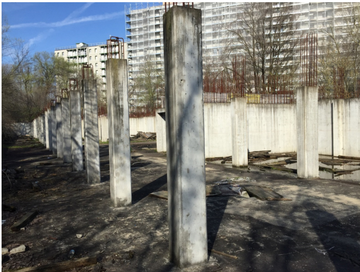
Foto 14 - Area urbana in corso di costruzione
