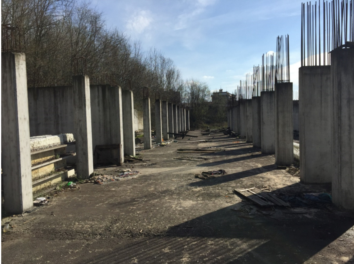
Foto 20 - Area urbana in corso di costruzione
