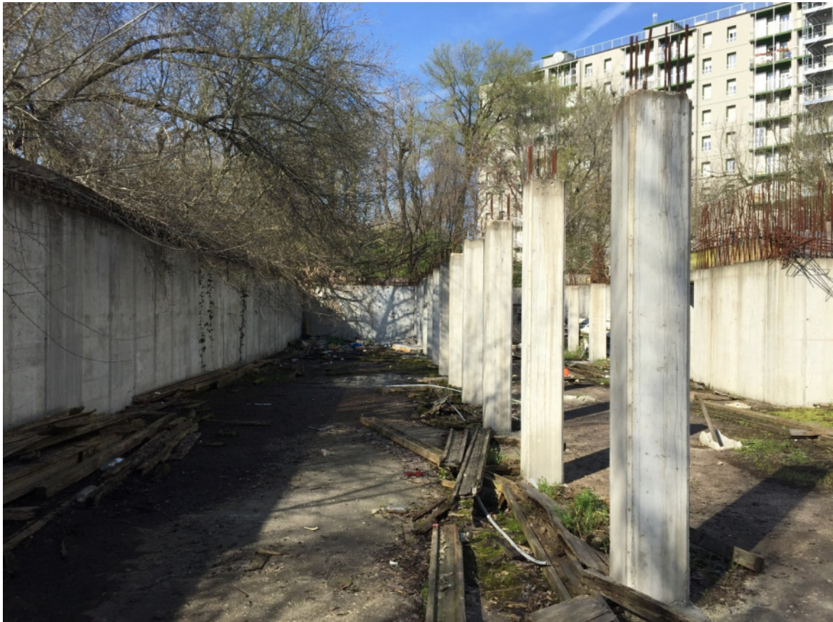
Foto 33 - Area urbana in corso di costruzione
