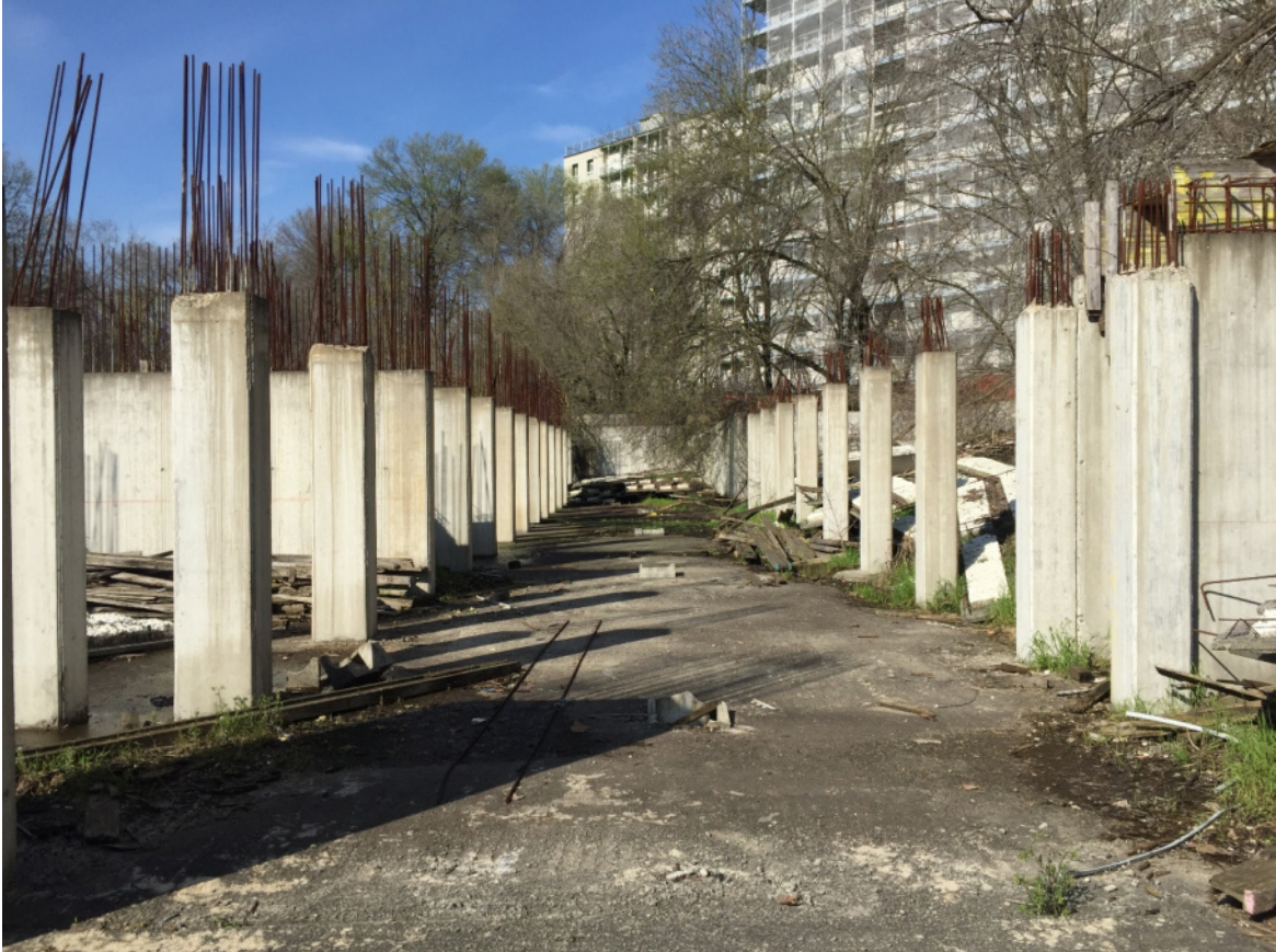
Foto 22 - Area urbana in corso di costruzione
