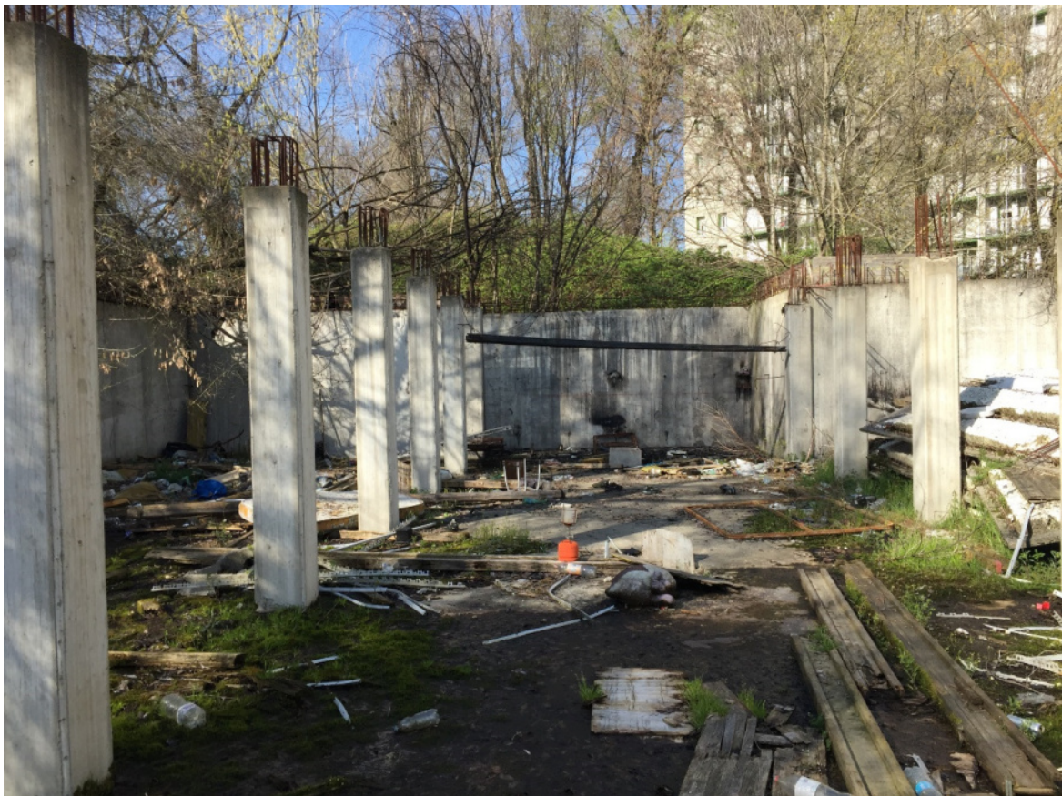
Foto 29 - Area urbana in corso di costruzione
