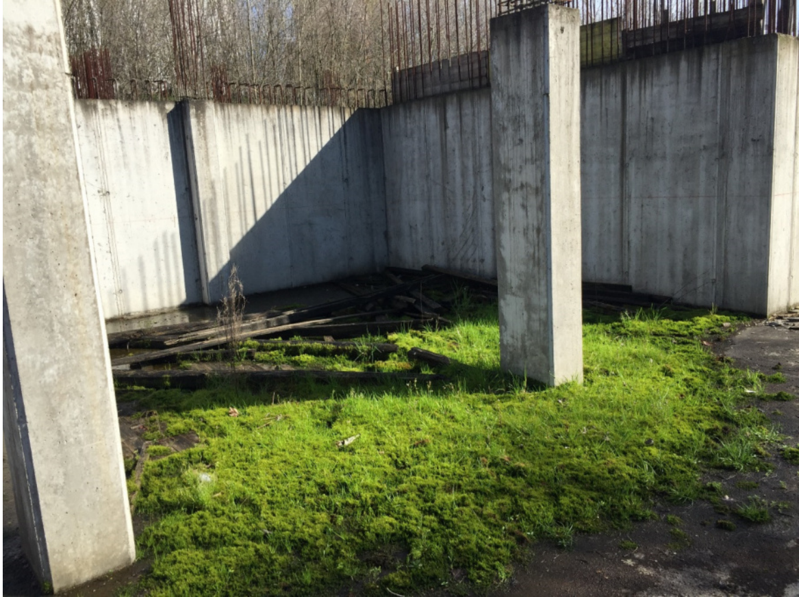
Foto 34 - Area urbana in corso di costruzione
