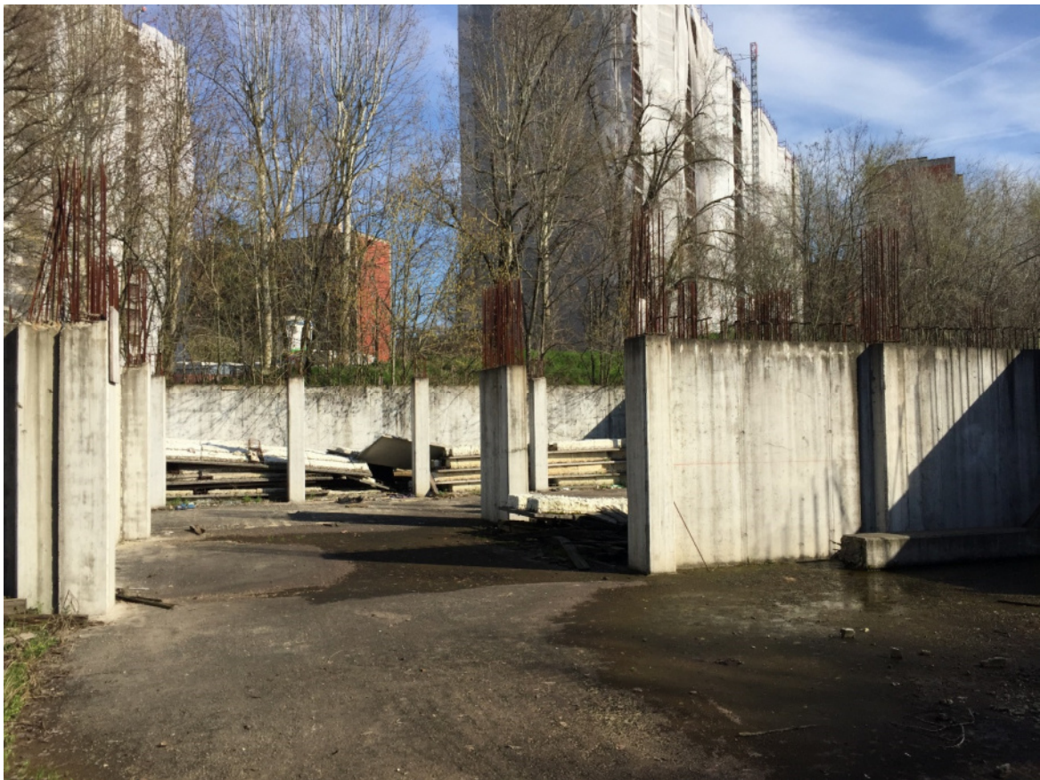
Foto 35 - Area urbana in corso di costruzione
