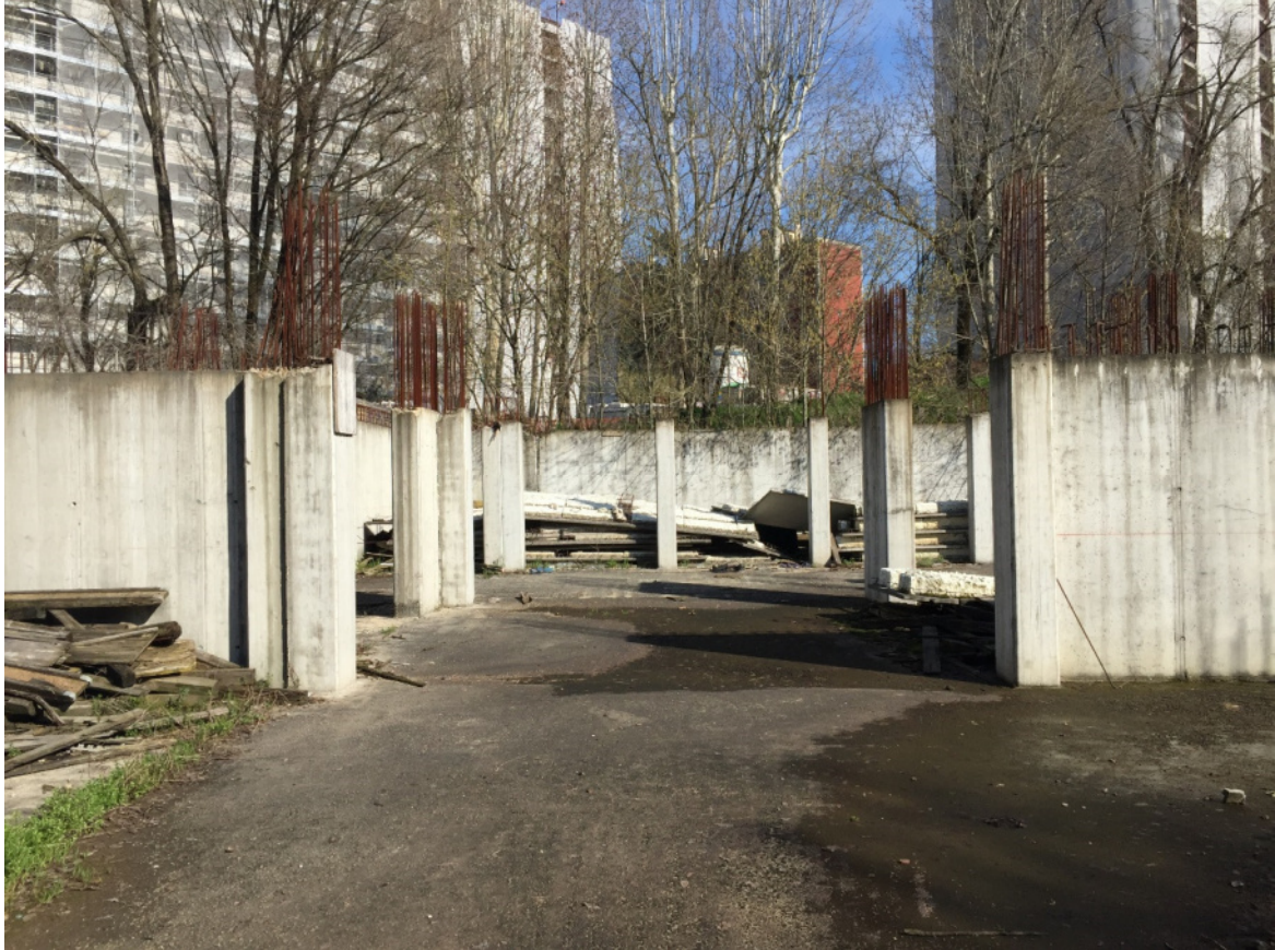
Foto 18 - Area urbana in corso di costruzione
