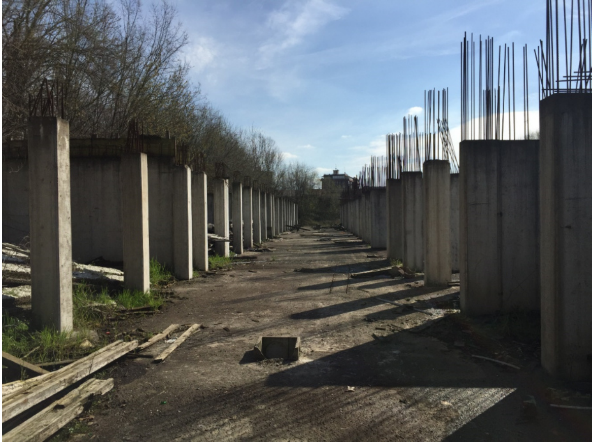
Foto 26 - Area urbana in corso di costruzione
