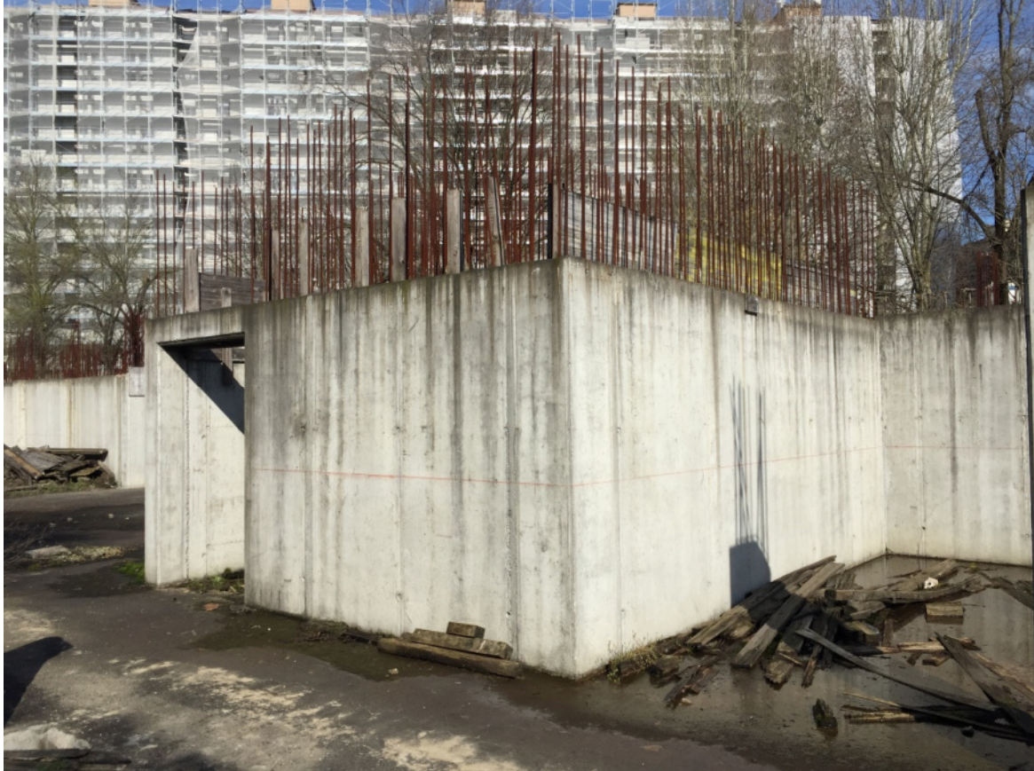
Foto 16 - Vano scale in corso di costruzione
