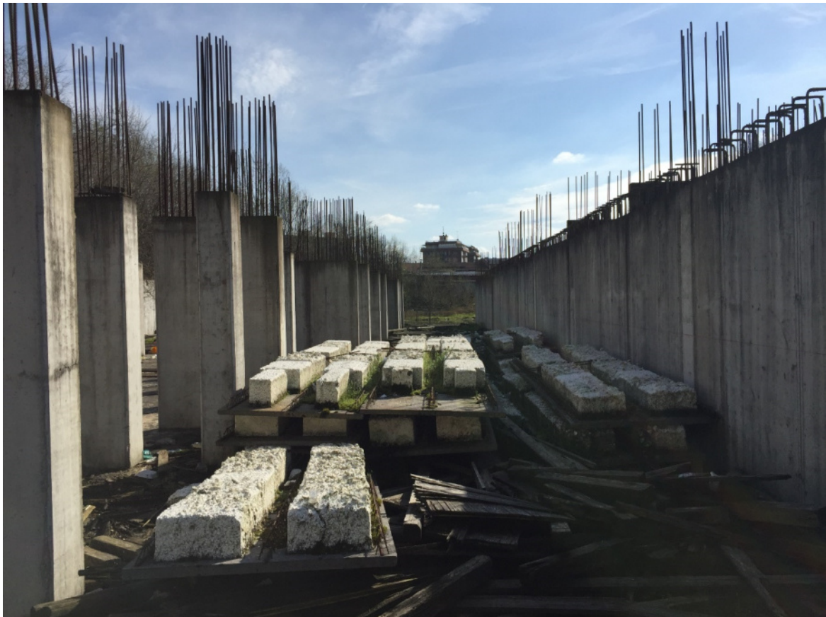
Foto 19 - Area urbana in corso di costruzione
