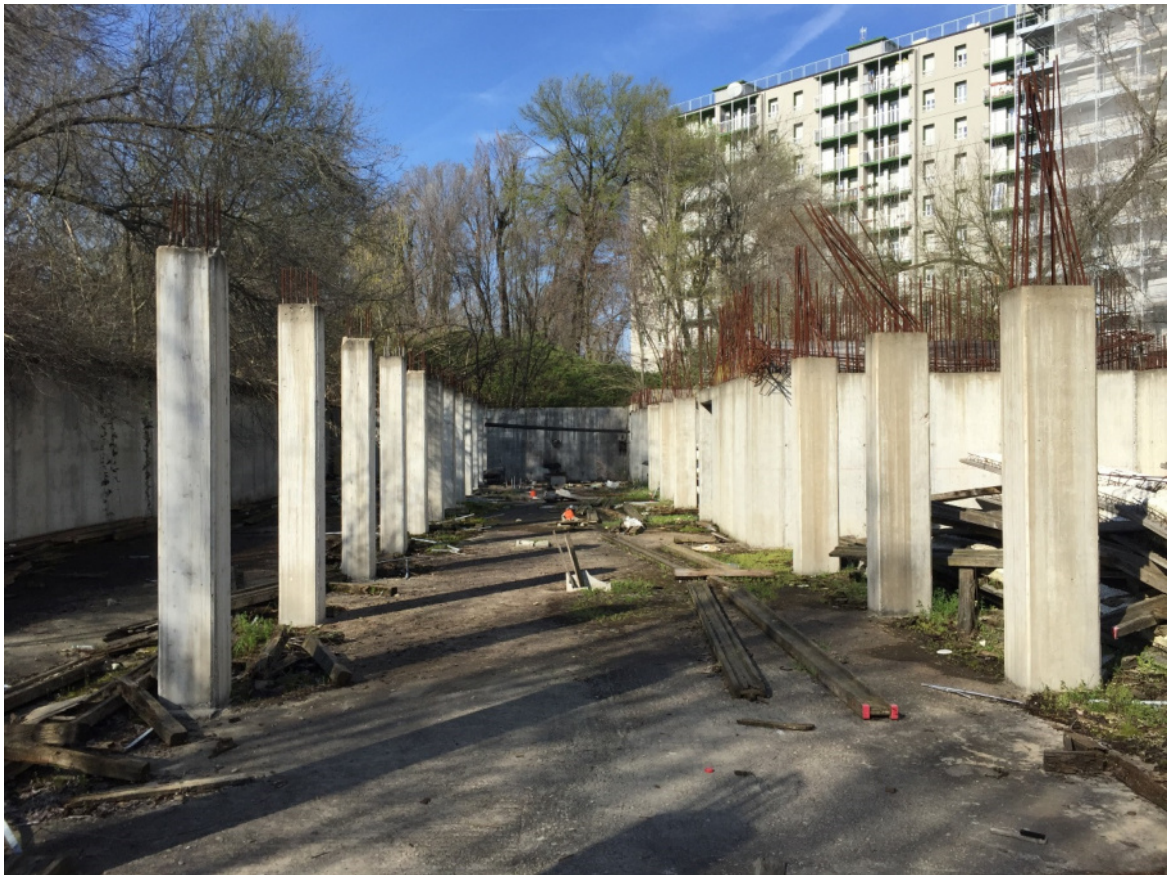
Foto 27 - Area urbana in corso di costruzione
