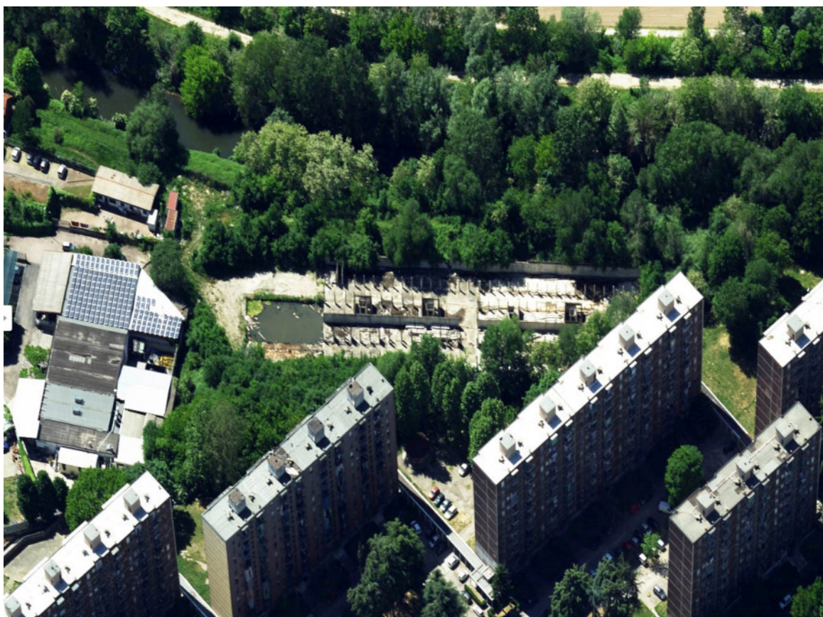
Foto 03 - Vista aerea dell'area urbana in corso di costruzione
