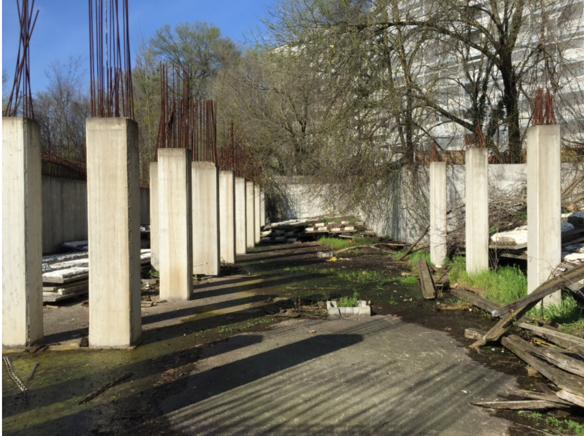
Foto 24 - Area urbana in corso di costruzione
