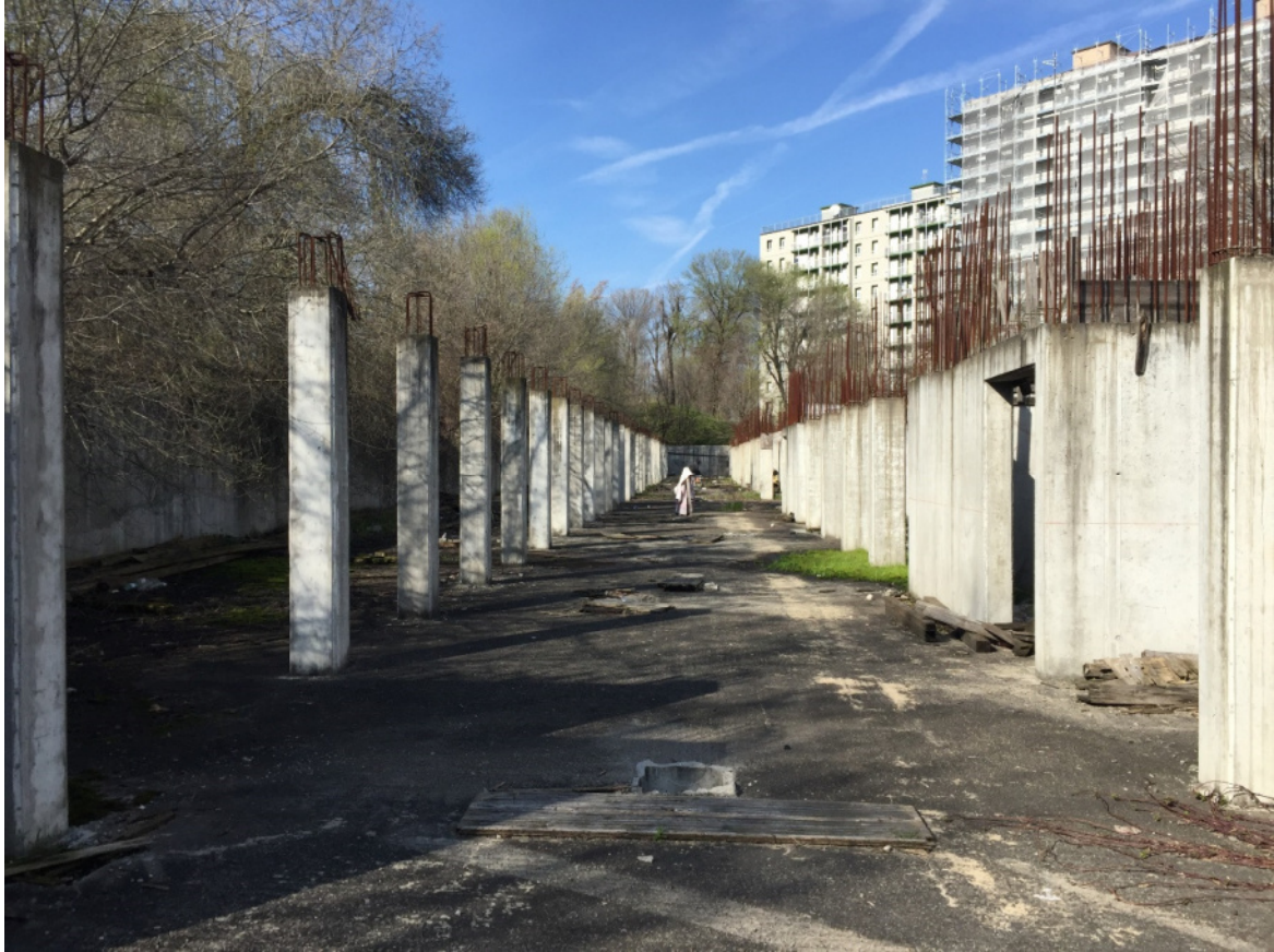
Foto 12 - Area urbana in corso di costruzione
