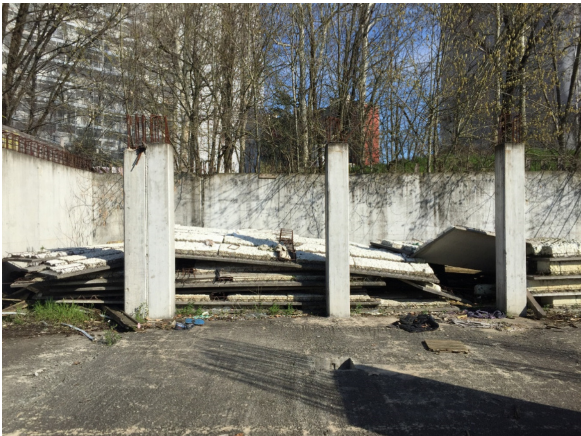
Foto 21 - Area urbana in corso di costruzione
