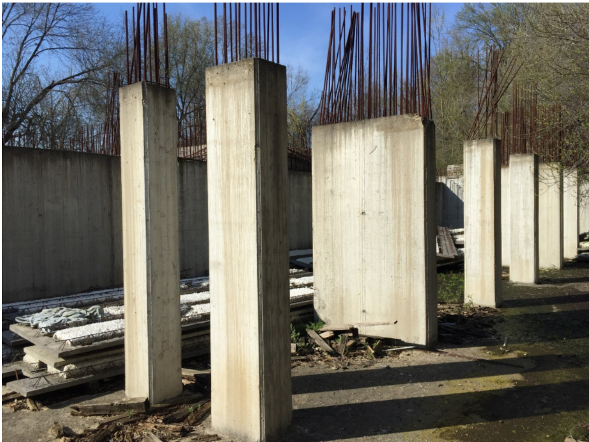
Foto 25 - Area urbana in corso di costruzione
