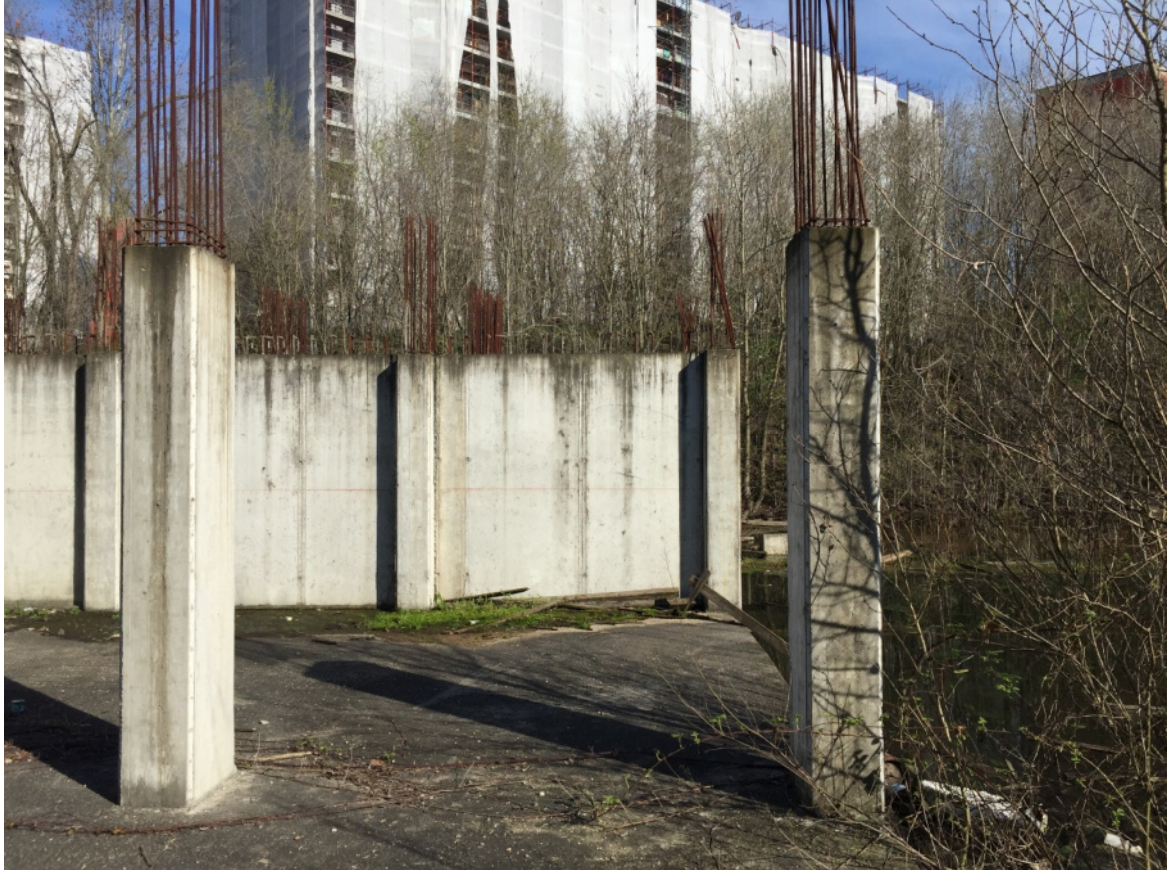
Foto 36 - Area urbana in corso di costruzione
