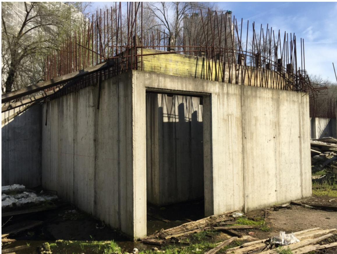
Foto 30 - Vano scale in corso di costruzione
