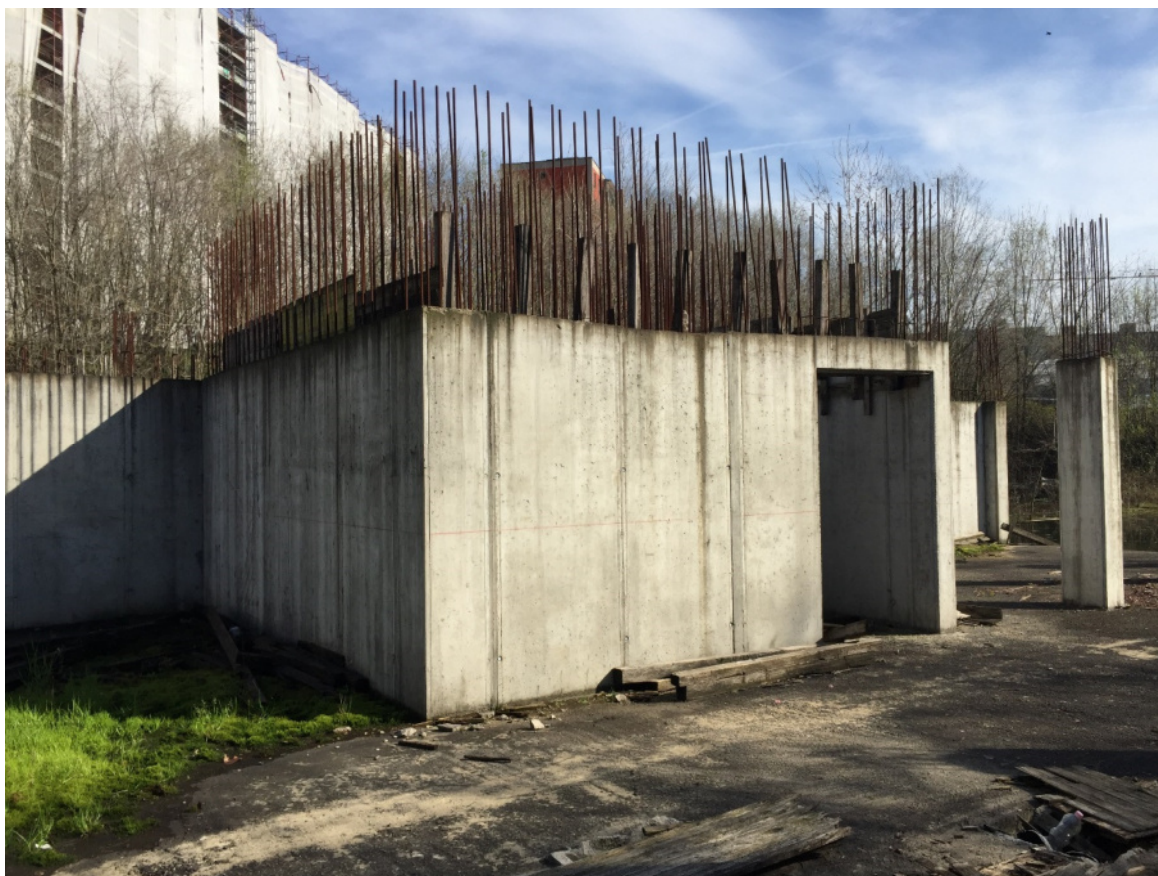
Foto 15 - Vano scale in corso di costruzione
