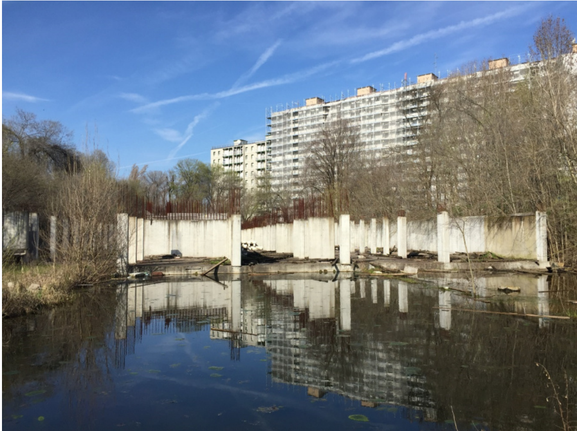
Foto 08 - Area urbana in corso di costruzione
