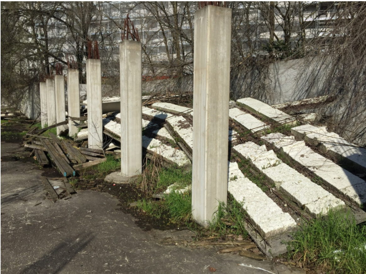
Foto 23 - Area urbana in corso di costruzione
