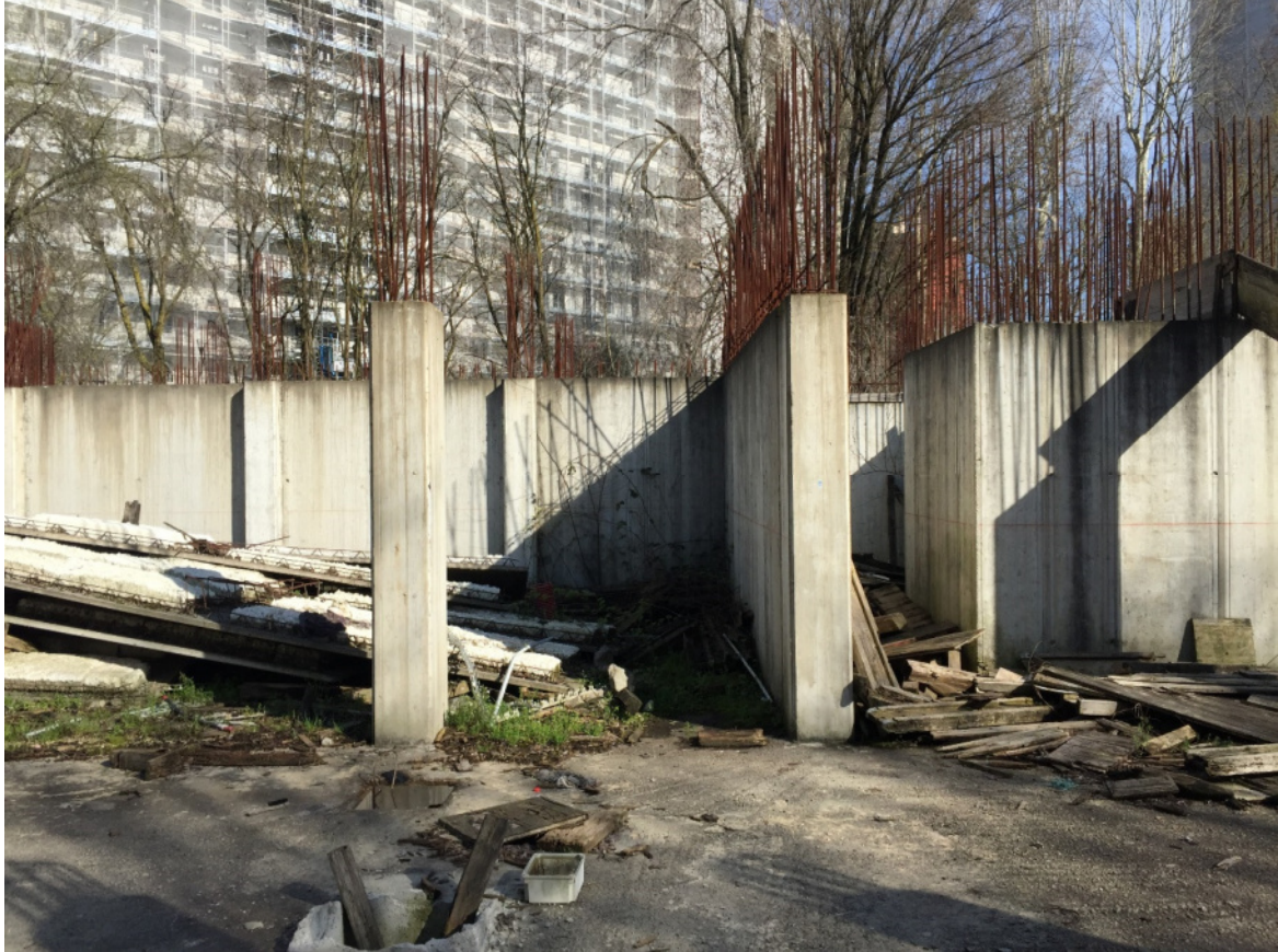
Foto 32 - Area urbana in corso di costruzione
