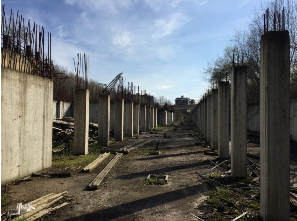
Foto 28 - Area urbana in corso di costruzione
