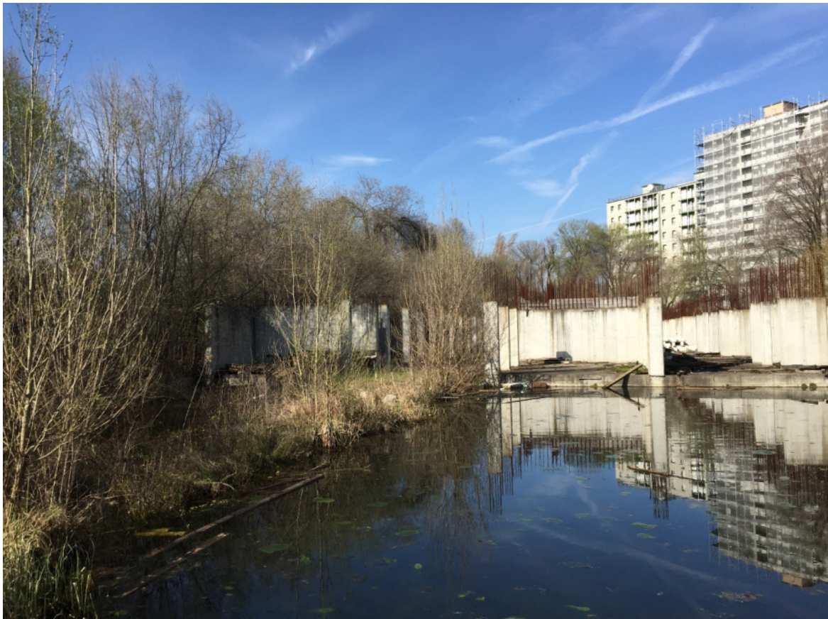
Foto 07 - Area urbana in corso di costruzione
