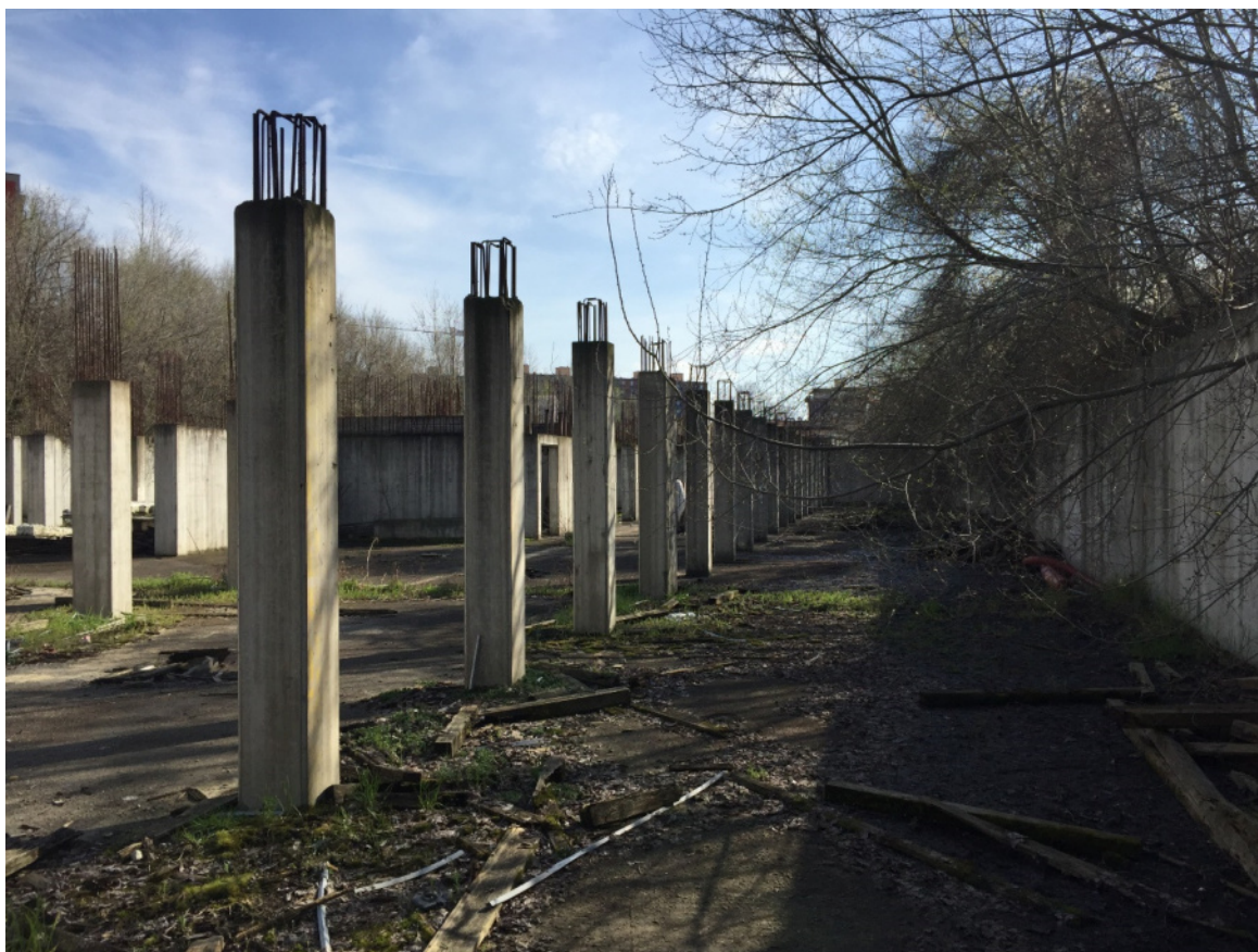
Foto 31 - Area urbana in corso di costruzione
