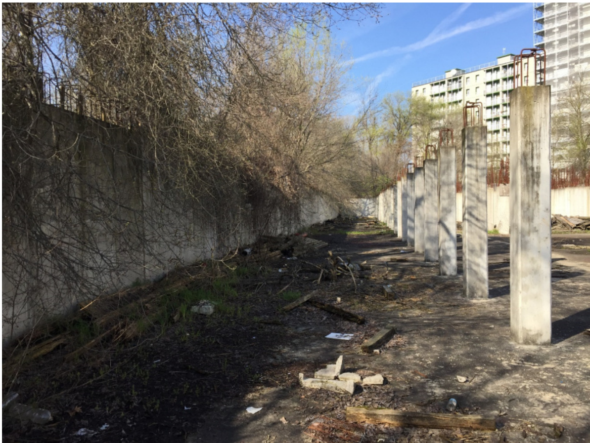
Foto 13 - Area urbana in corso di costruzione
