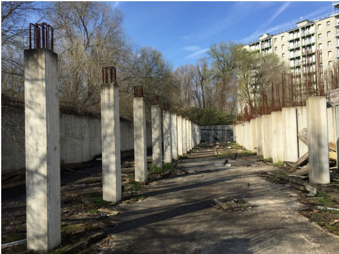
Foto 17 - Area urbana in corso di costruzione
