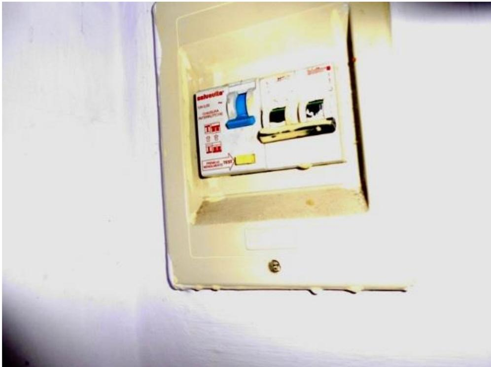
Figura 21- Quadro elettrico dell'alloggio – con salvavita
