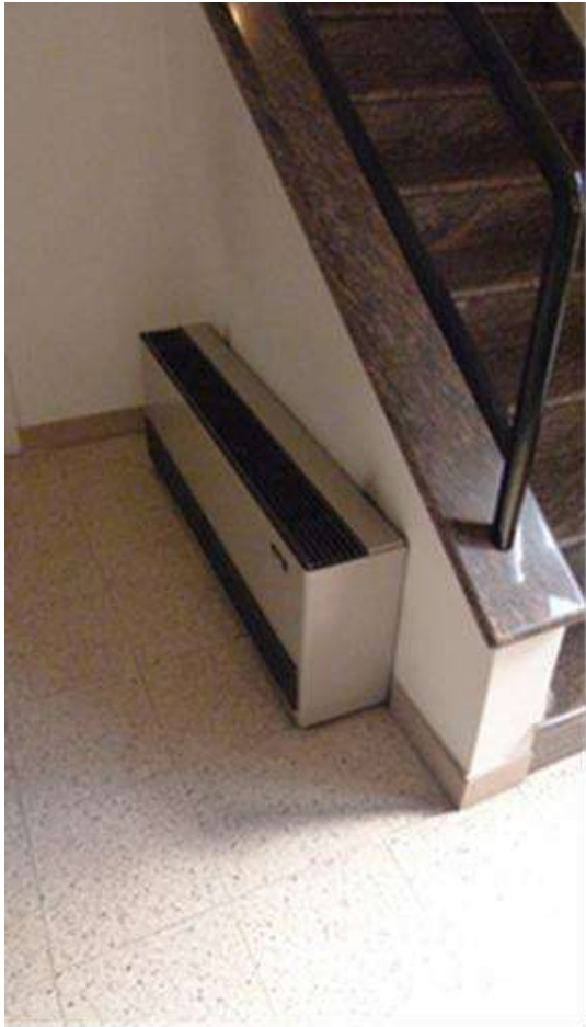
Foto n. 7 – Ingresso Piano terra
