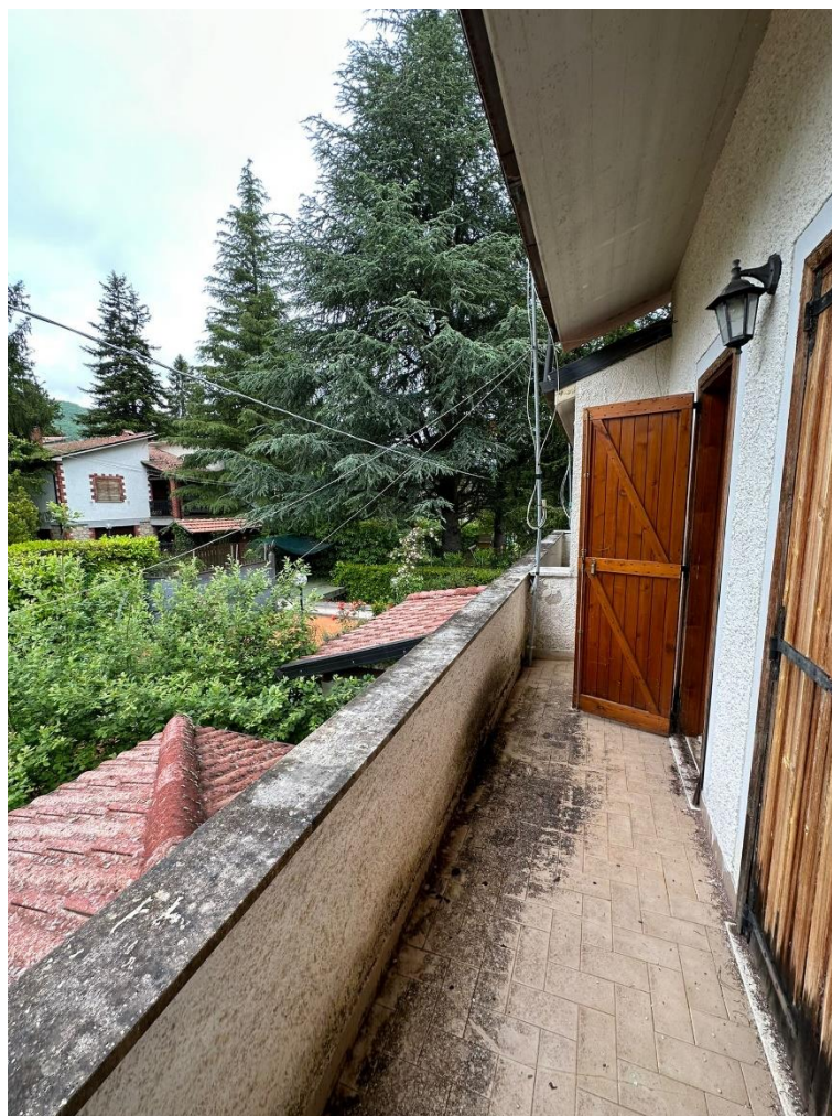
Foto n.18 – Balcone posto al piano primo
