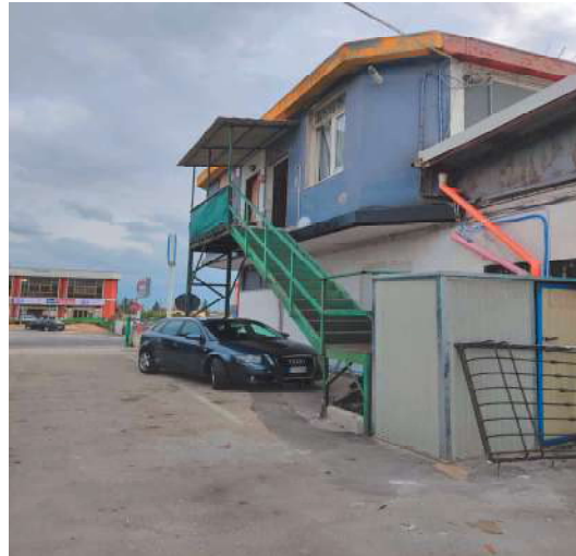
Foto 2: vista lato del piazzale esterno
