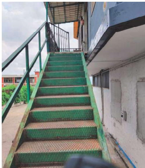
Foto 3: vista scala di accesso
