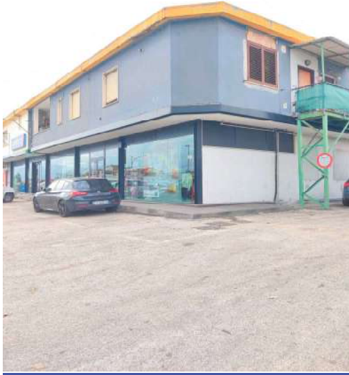
Foto 1: vista lato accesso di via Tiburtina Valeria
