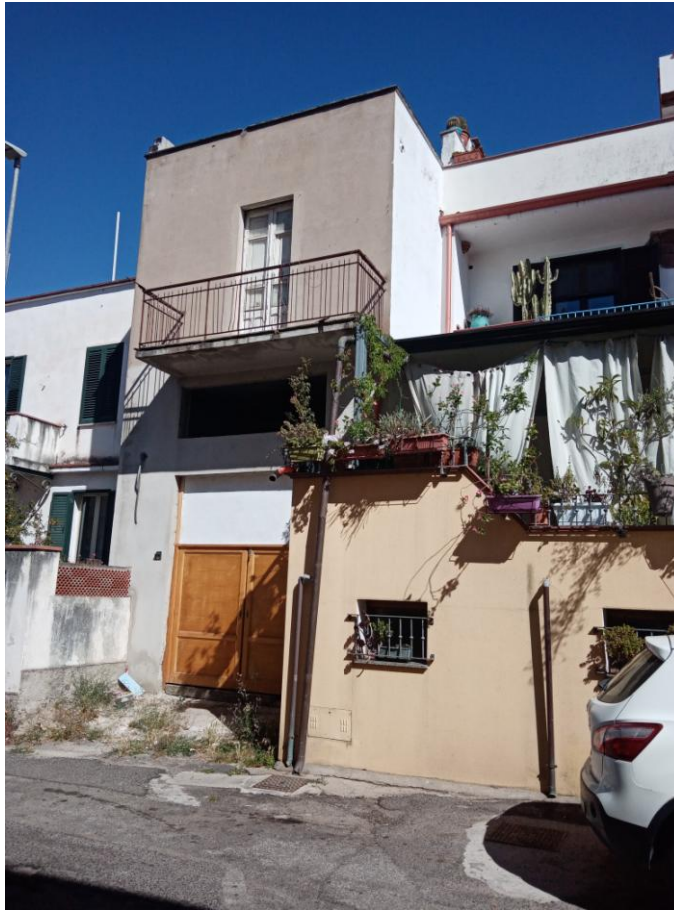
Foto 05_vista prospetto piano primo da Via Iglesias
