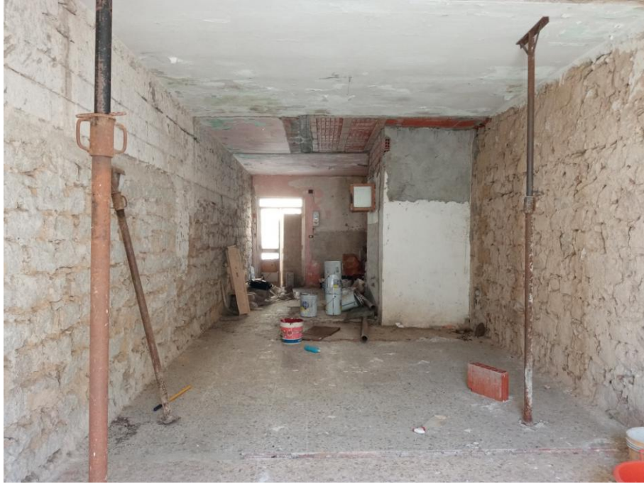
Foto 15_ vista interna dell'unità immobiliare in fase di ristrutturazione
