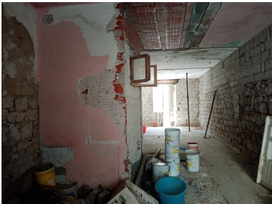
Foto 12_vista interna dell'unità immobiliare in fase di ristrutturazione
