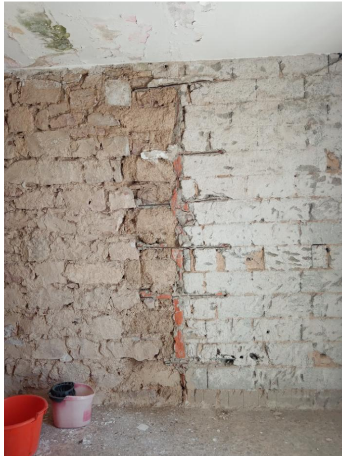
Foto 18_ particolare costruttivo della muratura portante perimetrale
