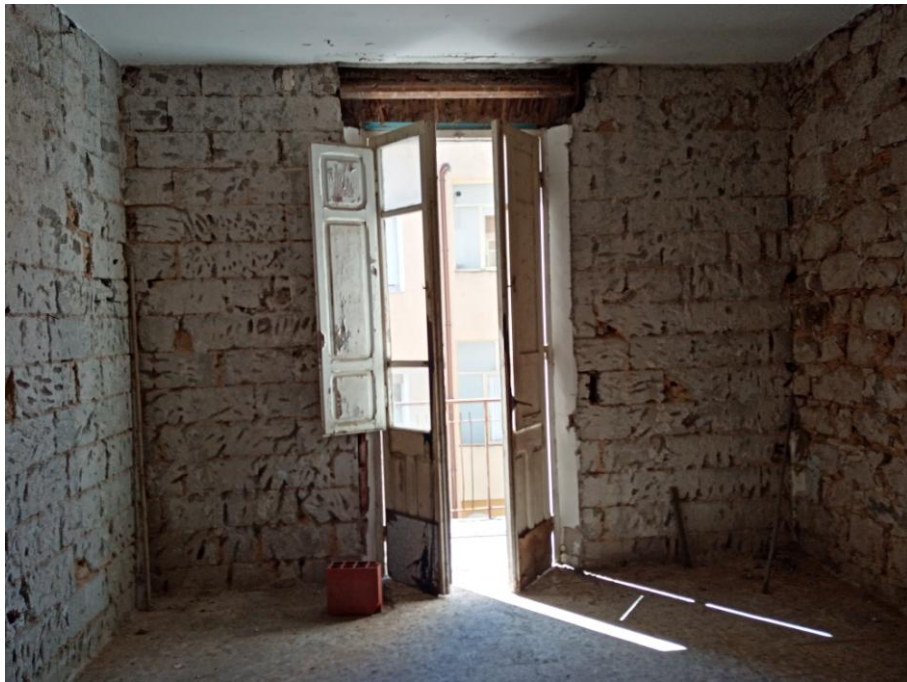
Foto 16_ vista interna della porta finestra in legno
