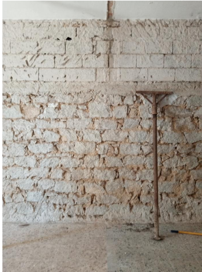
Foto 17_ particolare costruttivo della muratura portante perimetrale
