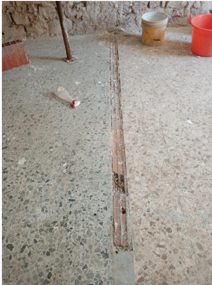
Foto 19_ particolare traccia della demolizione dei tramezzi interni
