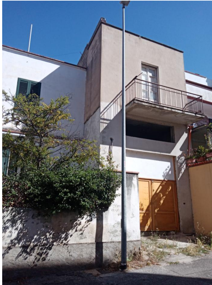
Foto 03_vista prospetto piano primo da Via Iglesias
