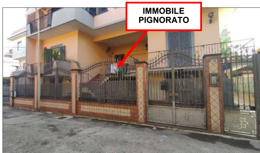
Cancello di ingresso sub nn. 1 e 2
