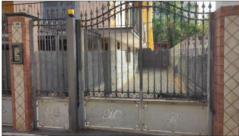
Cancello di ingresso sub 5
