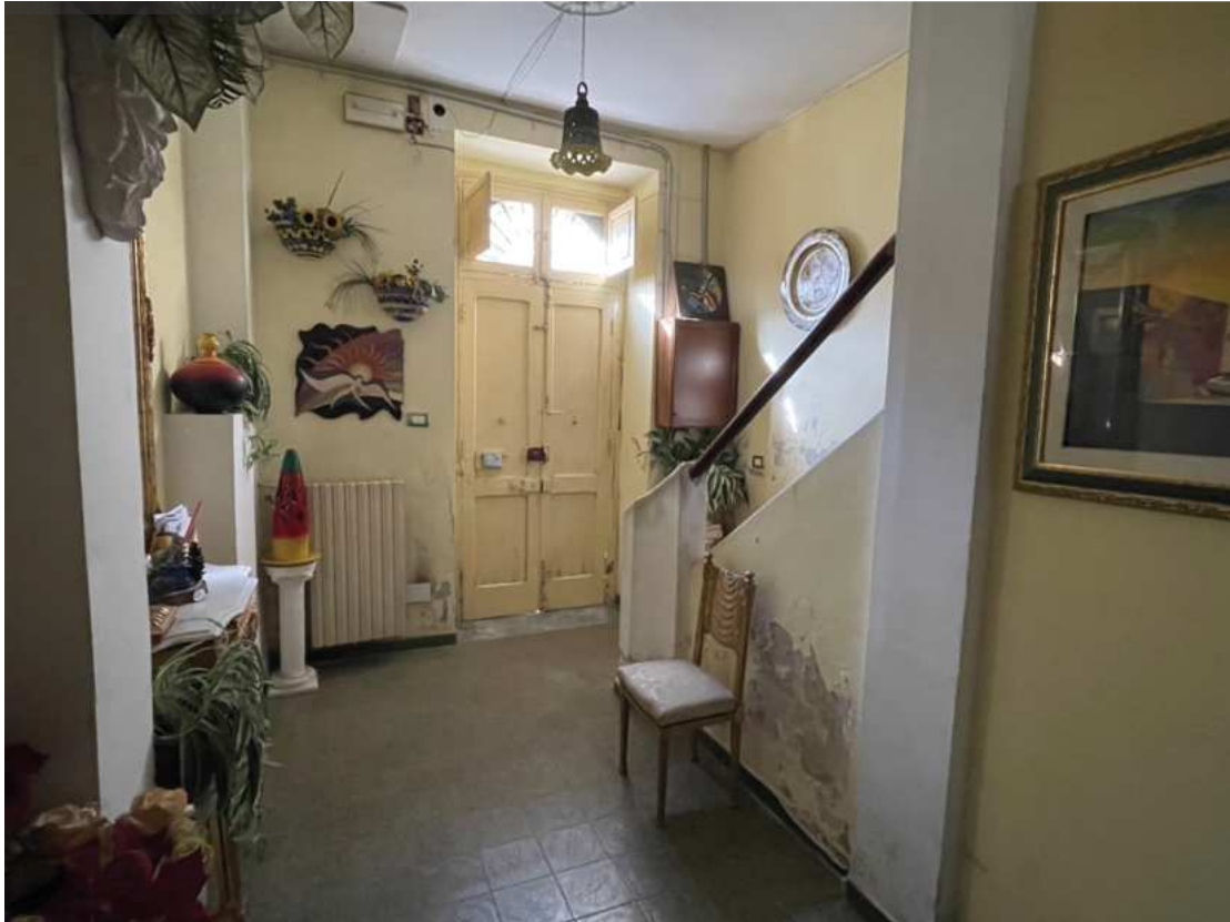
Foto 1 N.C.E.U. Sant'Onofrio fg. 6 - p.lla 724 sub 2
