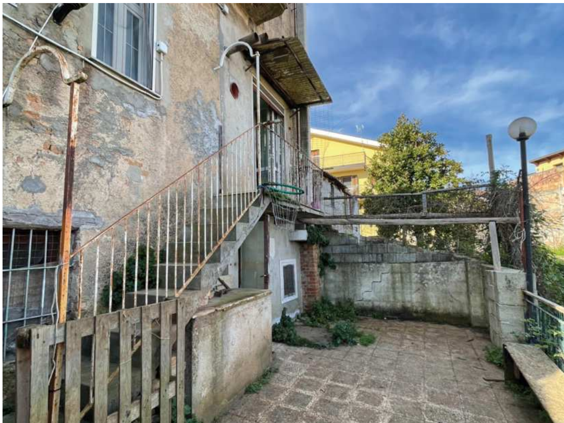
Foto 10 N.C.E.U. Sant'Onofrio fg. 6 - p.lla 724 sub 2 cortile
