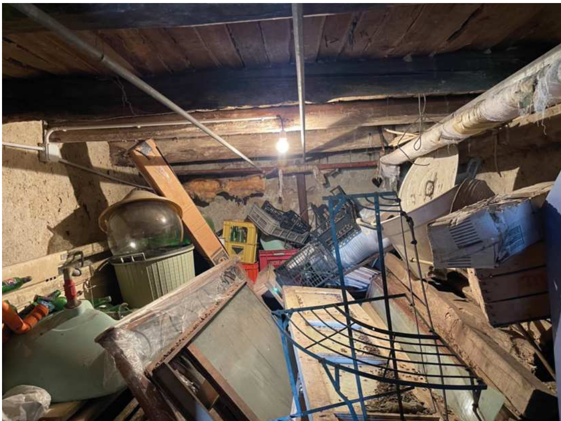
Foto 12 N.C.E.U. Sant'Onofrio fg. 6 - p.lla 724 sub 2 cortile (seminterrato)
