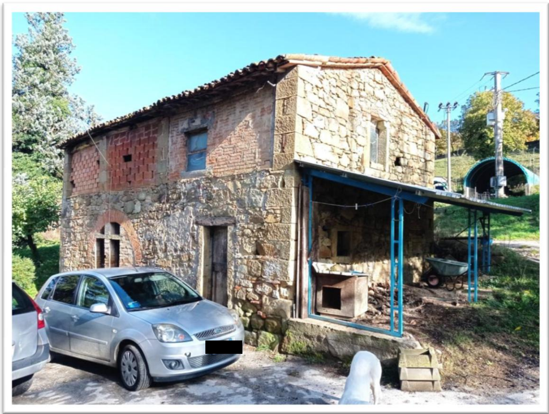
Foto 9 – Locale ad uso fondo e magazzino, esterno prospetto EST e SUD
