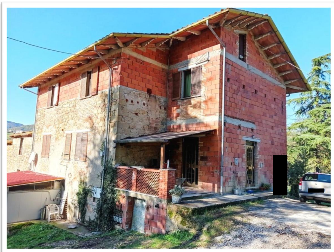
Foto 2 – Esterno edificio residenziale, prospetto SUD ed OVEST
