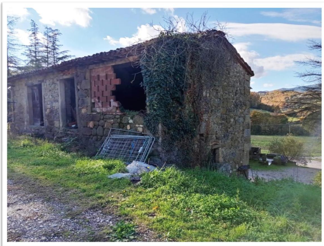
Foto 11 – Locale ad uso fondo e magazzino, esterno prospetto OVEST e NORD
