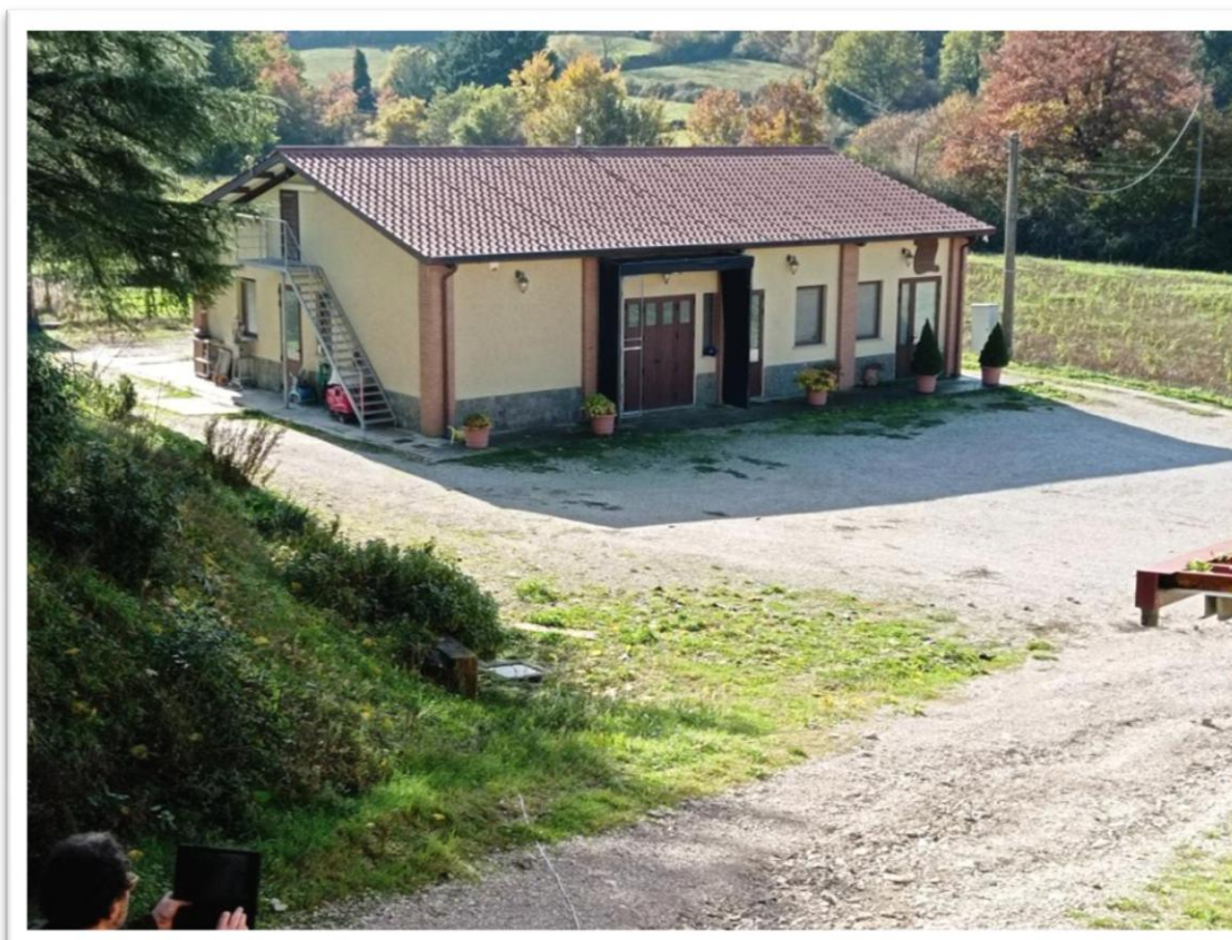
Foto 12 – Edificio a destinazione commerciale, esterno, prospetto NORD ed OVEST
