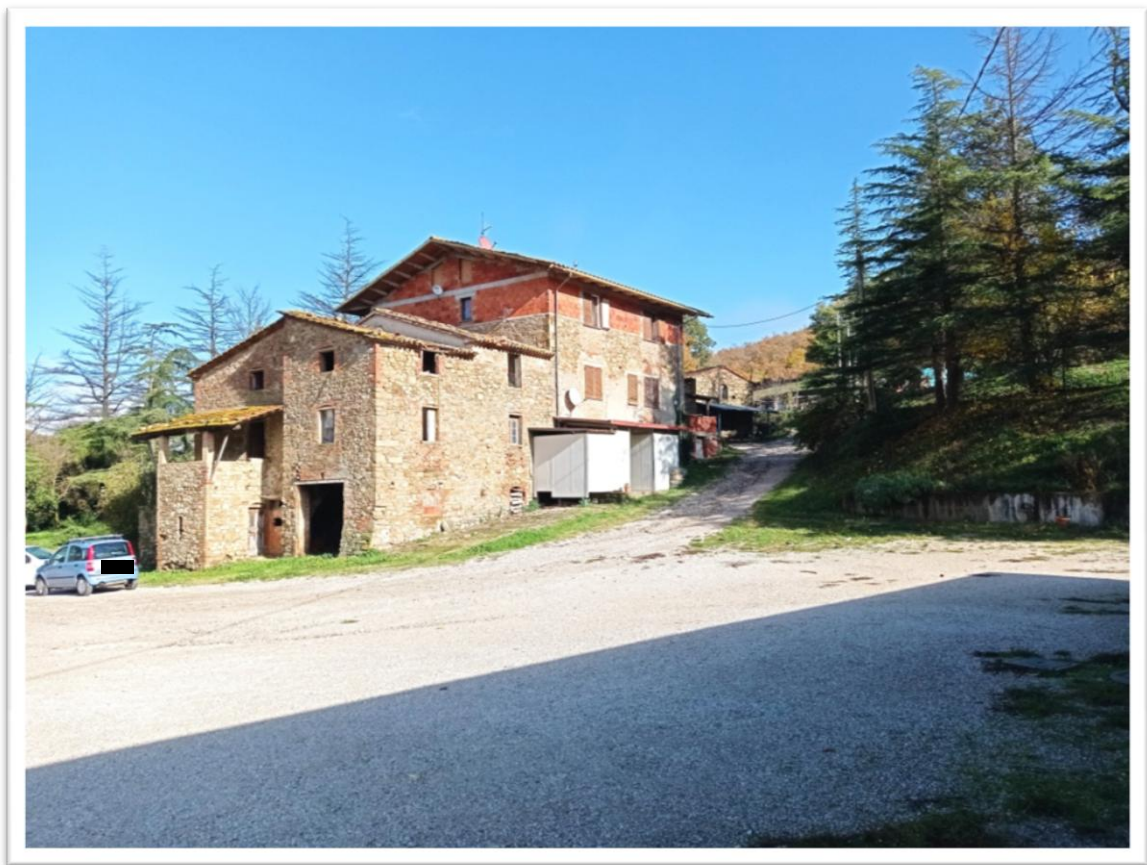
Foto 1 – Esterno edificio residenziale, prospetto SUD ed EST
