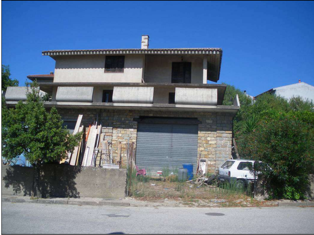
Foto n. 19: accesso esterno al locale artigianale al piano seminterrato
