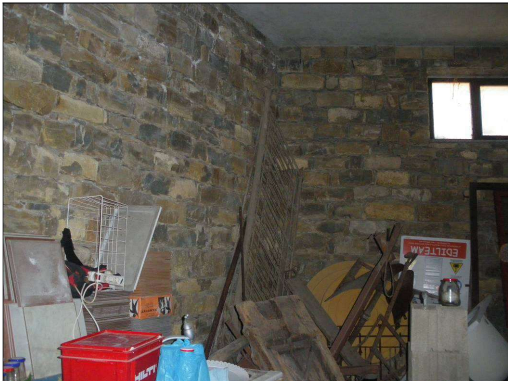
Foto n. 18: locale artigianale al piano seminterrato
