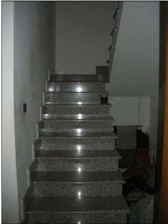
Foto n. 9: Scala di accesso al piano primo
