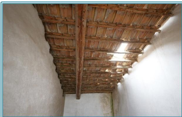
Figura 107 Dettaglio dello stato degradante della copertura
