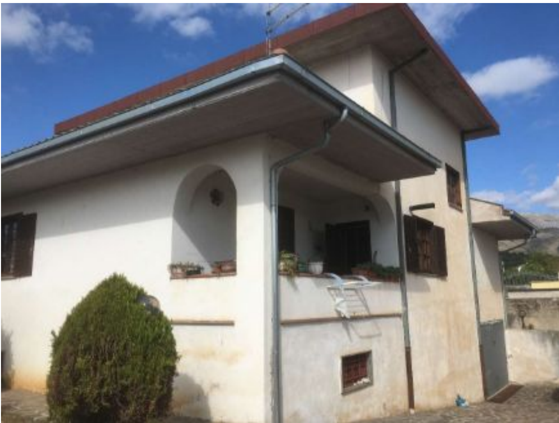
Vista esterna del lato sud est con rampa per il garage
