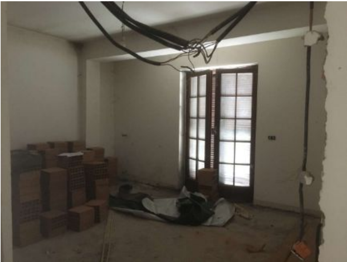
Primo piano con demolizione di tramezzi e pavimenti.
