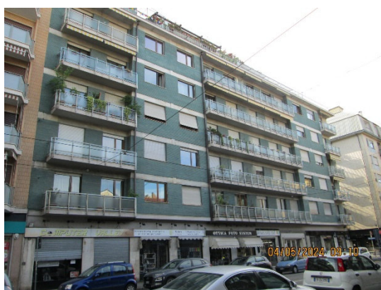
Facciata del fabbricato su via Nizza 141
