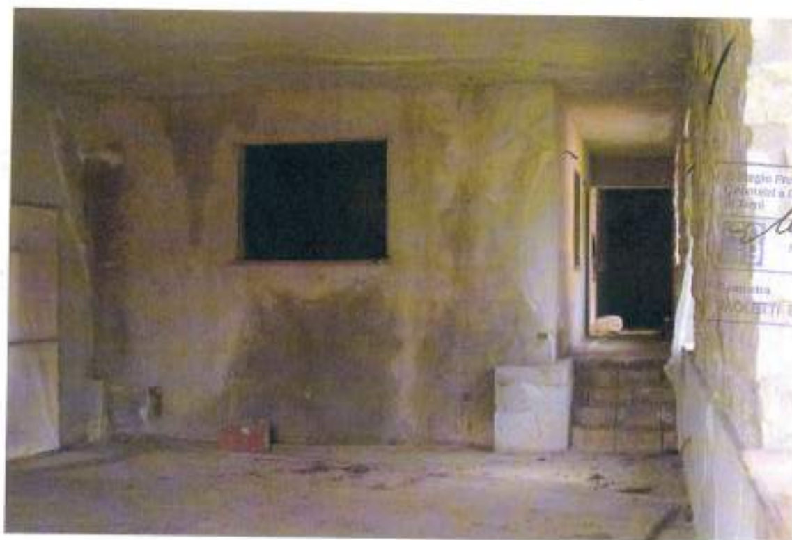
INTERNO FABBRICATO H (PIANO SEMINTERRATO)
