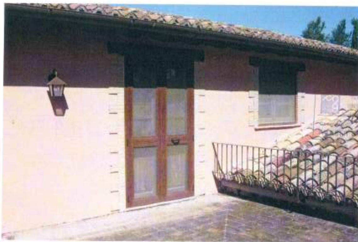
ESTERNO FABBRICATO È (RISTORANTE) TERRAZZA P. 1°
