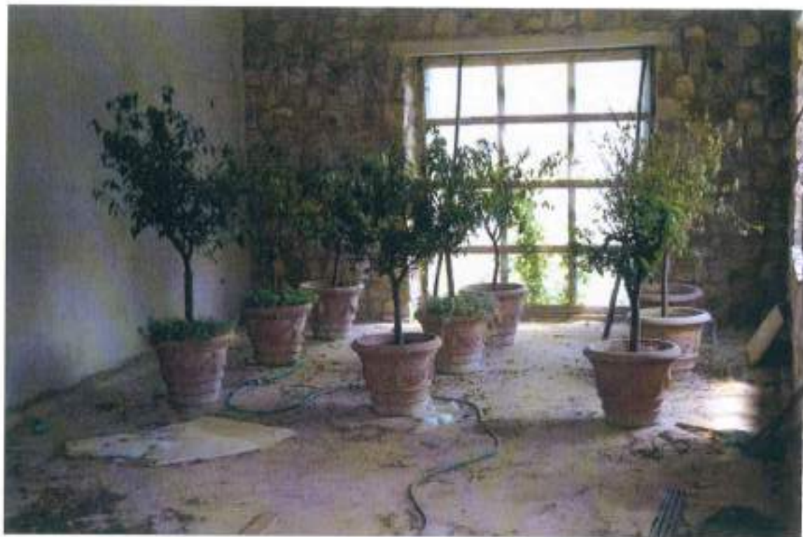
INTERNO FABBRICATO H (PIANO SEMINTERRATO)
