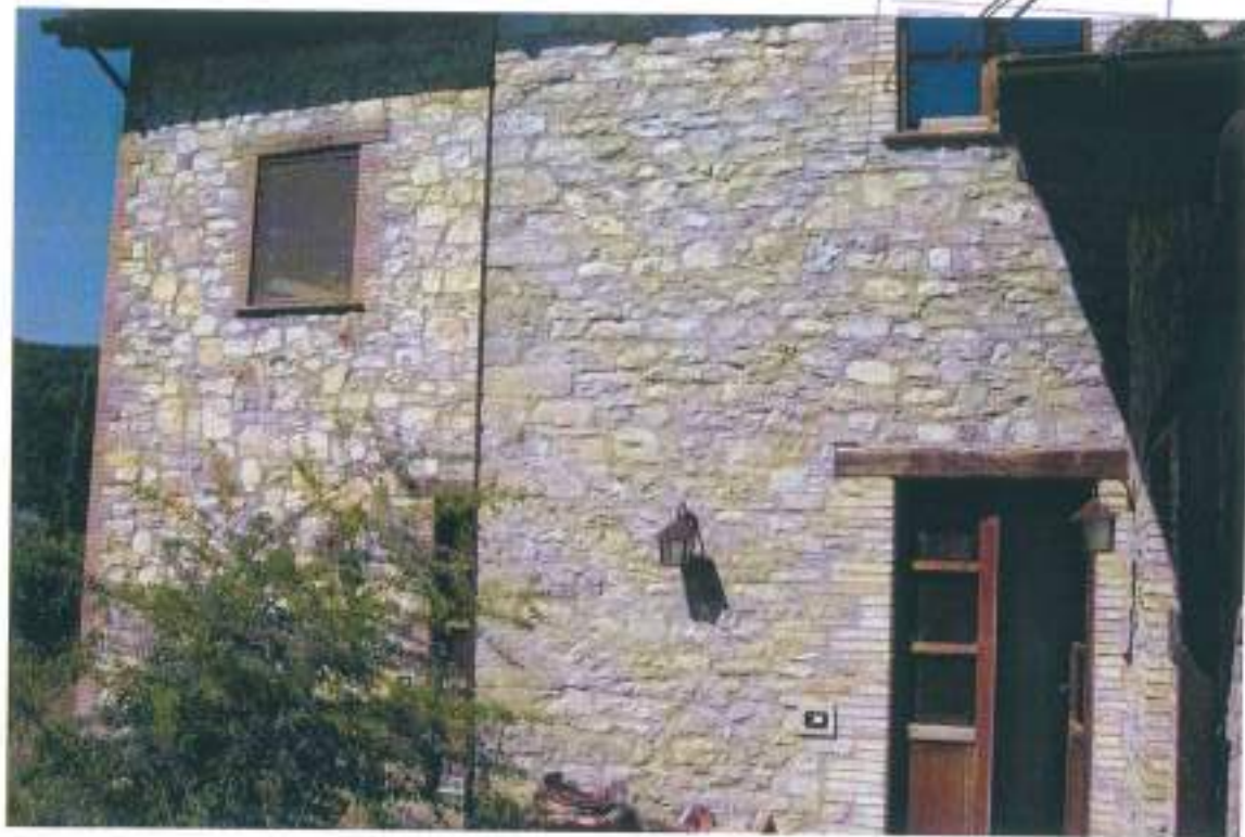
ESTERNO FABBRICATO D (P.LA 61)
