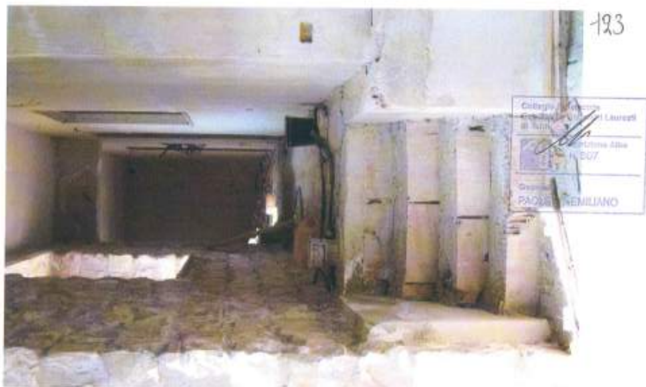
INTERNO FABBRICATO H (PIANO SEMINTERRATO)
