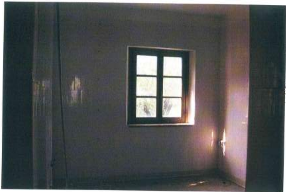
INTERNO FABBRICATO E (RISTORANTE) - PIANO TERRA (CUCINE)
