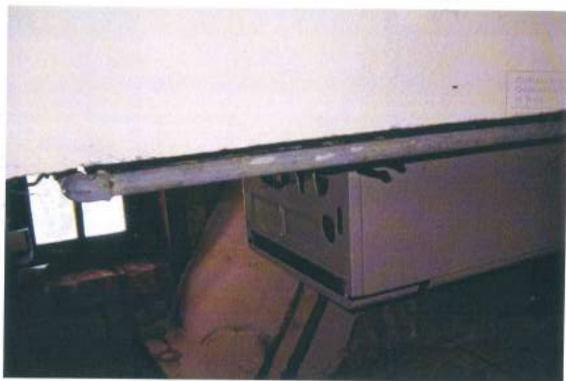
INTERNO FABBRIGATO E1 (P.LLA 54) - PIANO TERRA
