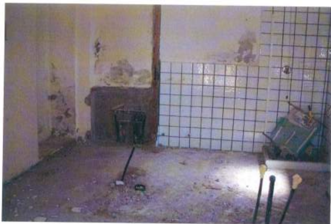
INTERNO FABBRICATO D (P.LA 61) - PIANO TERRA
