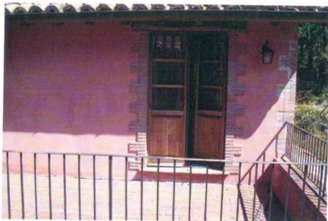
ESTERNO FABBRICATO E2 (P.LLA 58) - PIANO PRIMO (TERRAZZA)
