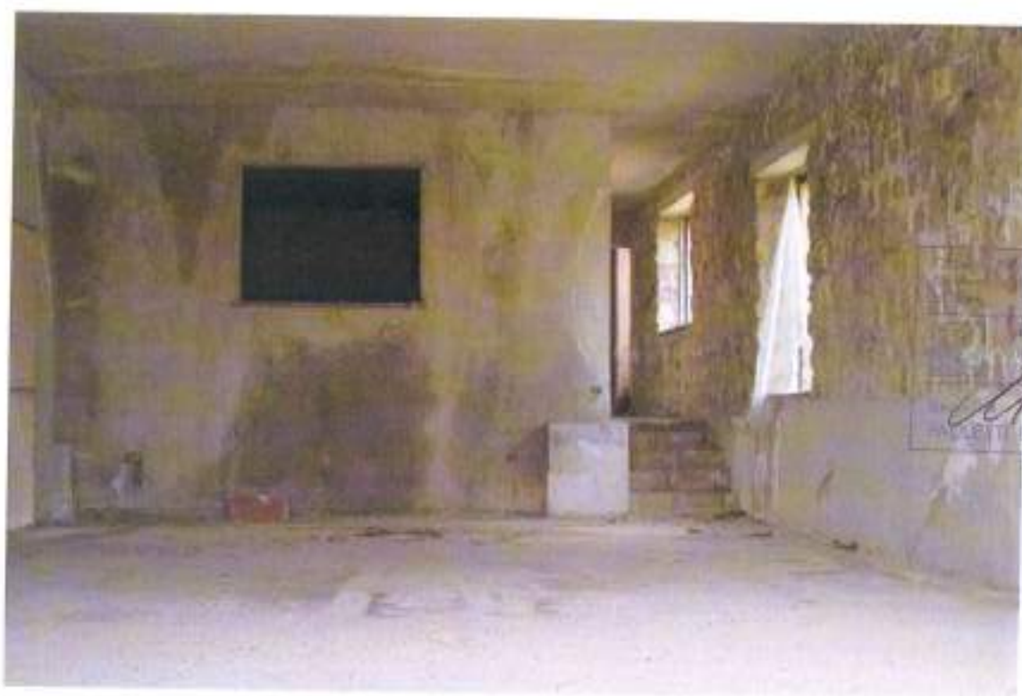
INTERNO FABBRICATO H (PIANO SEMINTERRATO)
