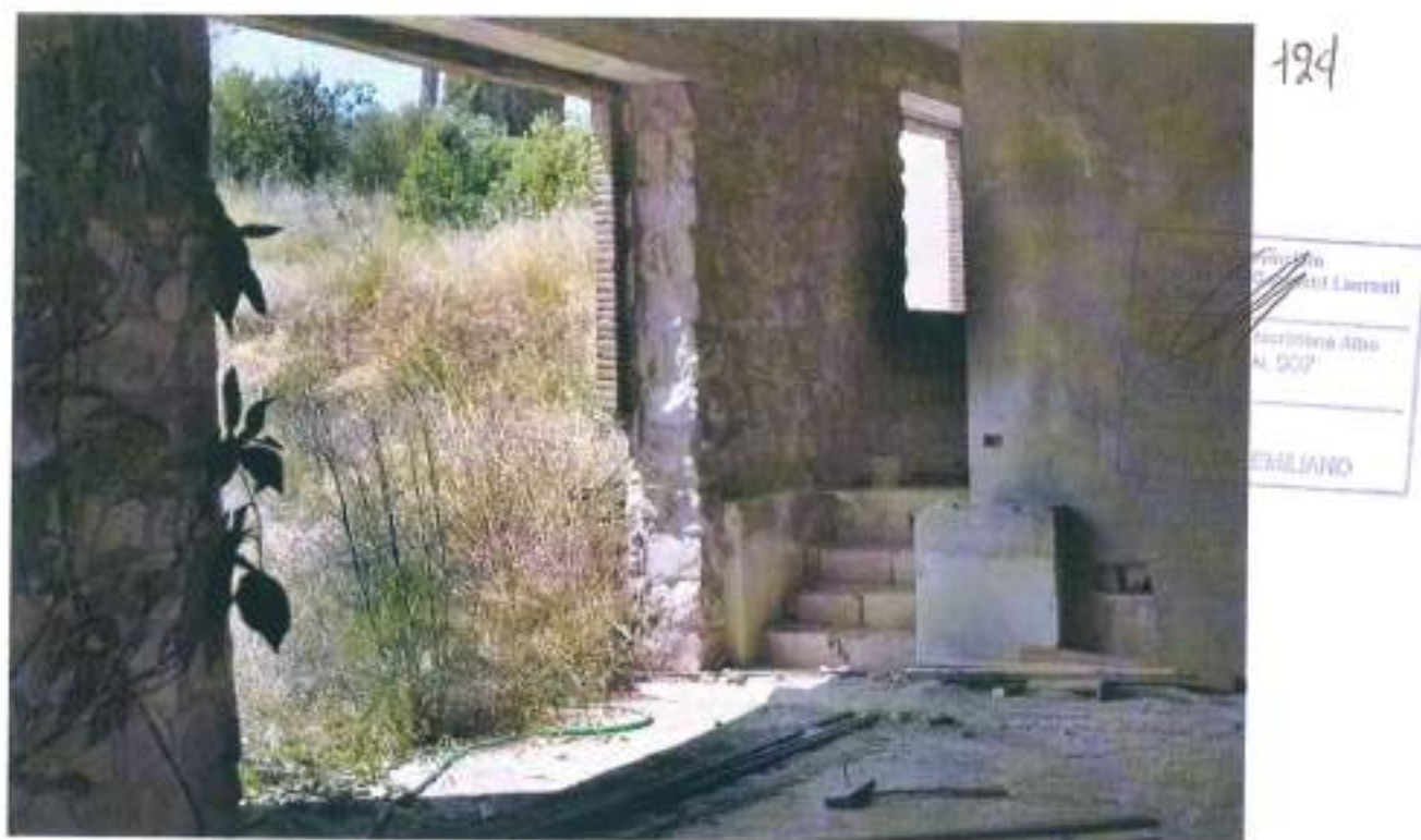
INTERNO FABBRICATO H (PIANO SEMINTERRATO)
