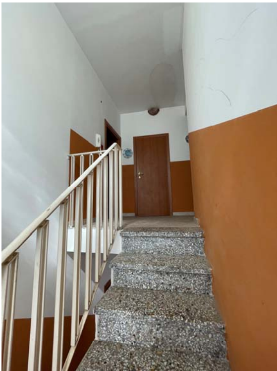
Vista della scala interna in corrispondenza dell'ingresso
