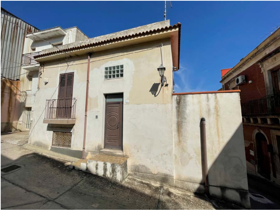
Vista esterna dell'immobile
