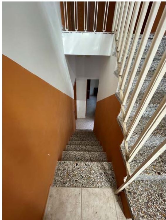
Vista della scala interna in corrispondenza dell'ingresso
