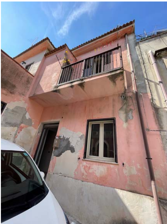
Vista esterna dell'immobile
