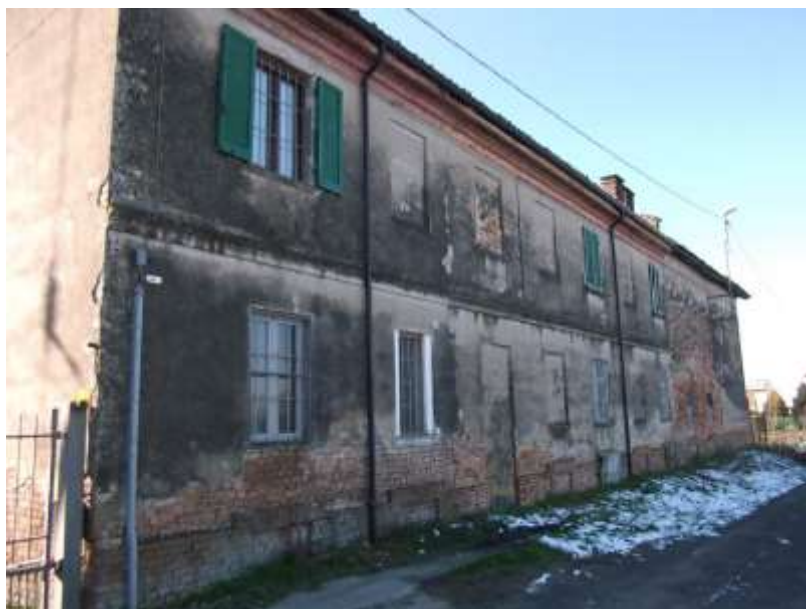
Foto 2: vista da strada Capalla.
