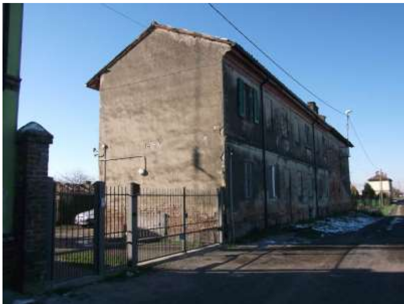
Foto 1: vista da strada Capalla.
