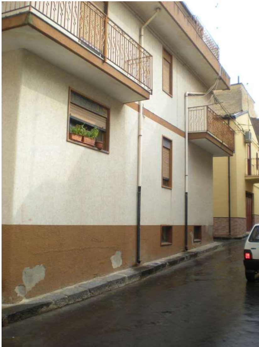
Foto 3: Dettagli facciata laterale lato ovest (via Roma)
