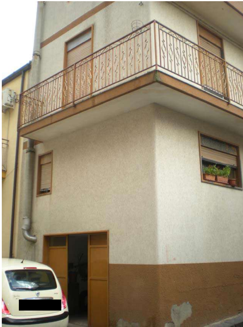
Foto 24: Ingresso esterno garage
