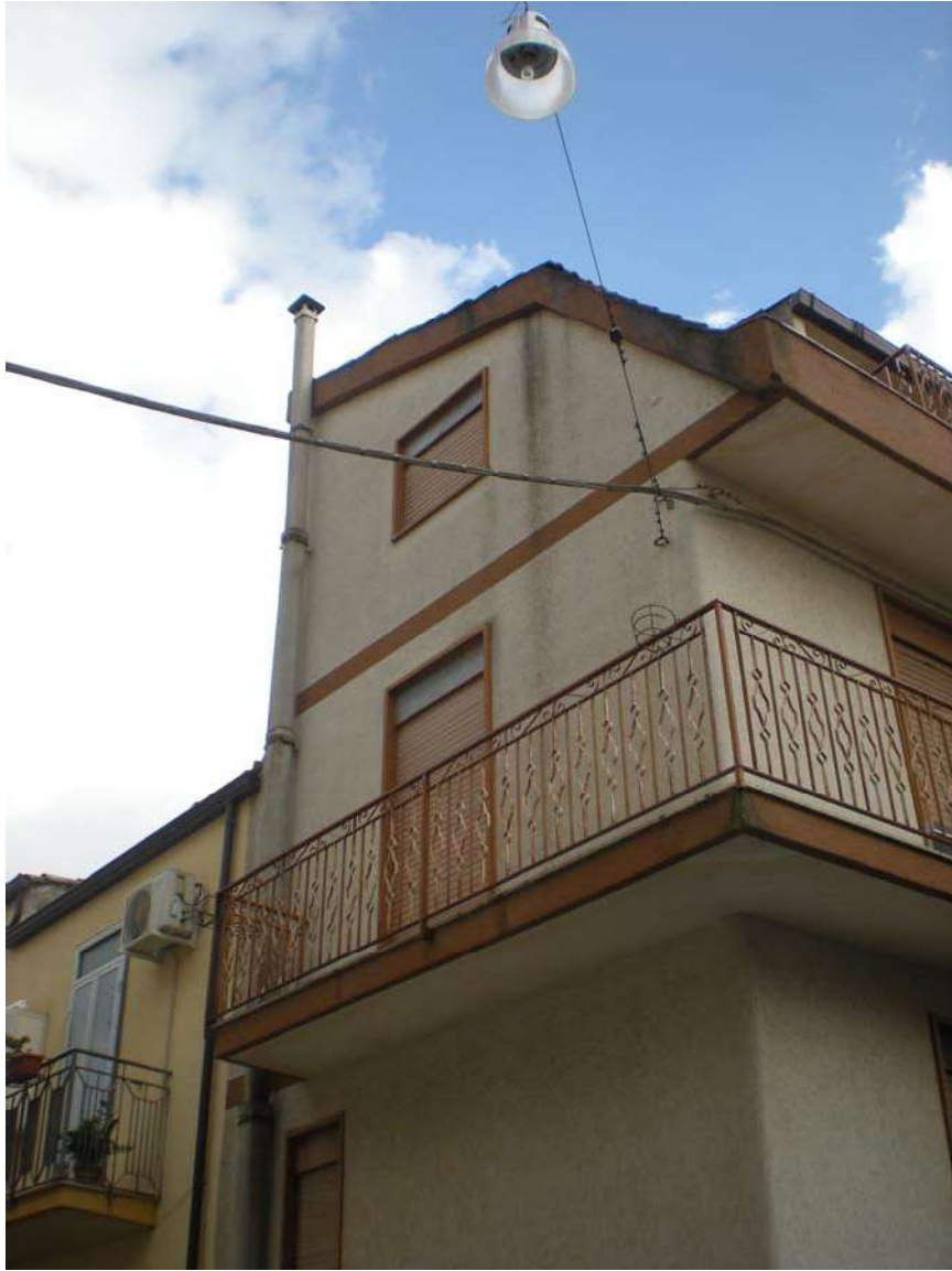
Foto 4: Dettagli facciata laterale lato nord (via Rinaldi)
