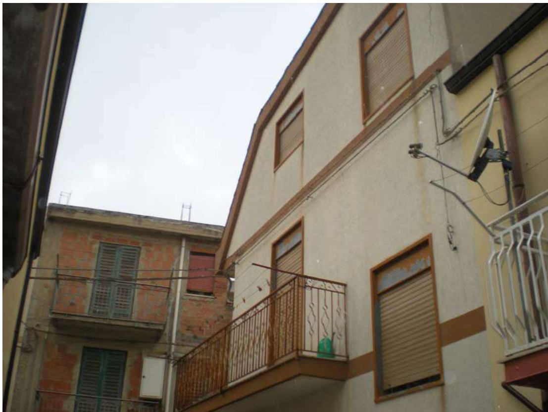
Foto 2: Dettagli facciata principale lato sud (via Marasà)
