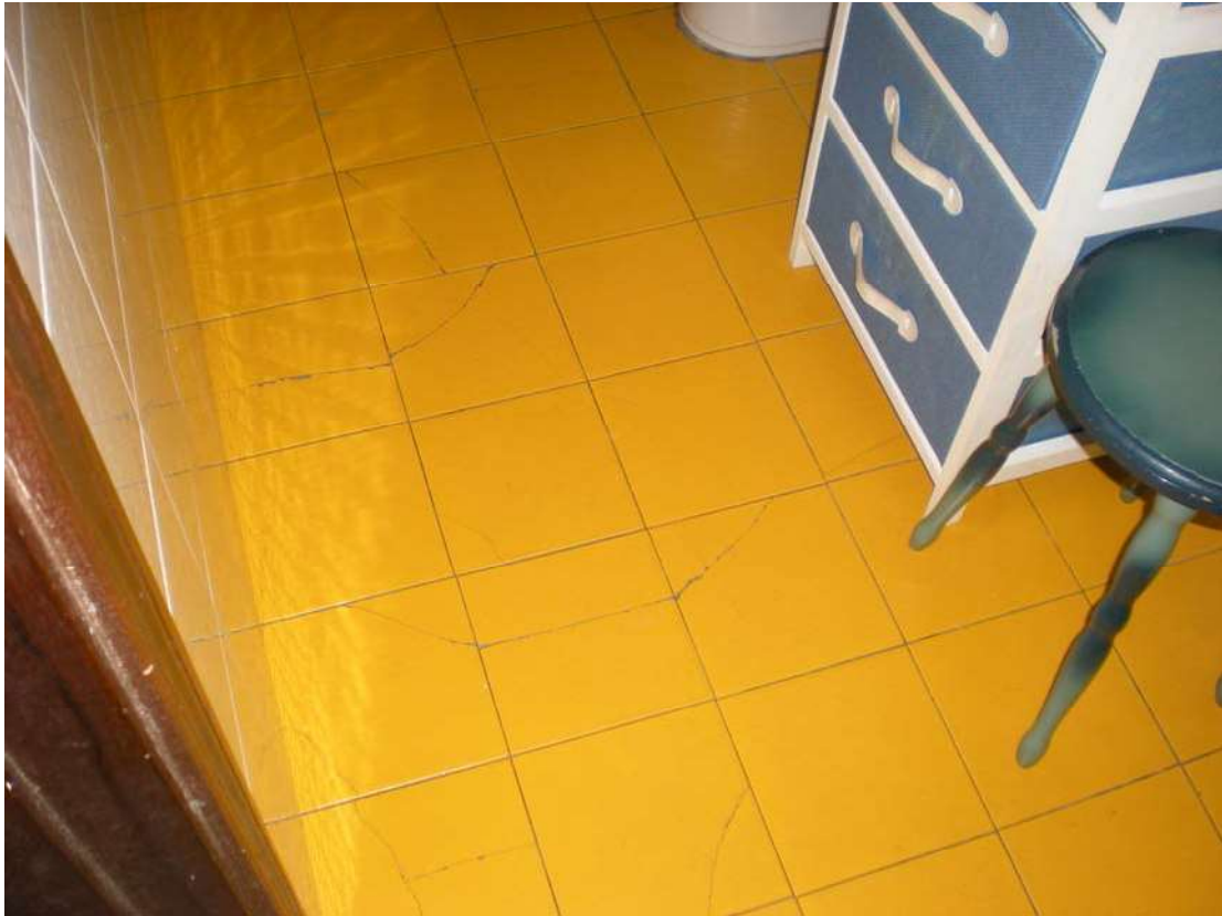
Foto 11: Dettaglio pavimento bagno piano terra
