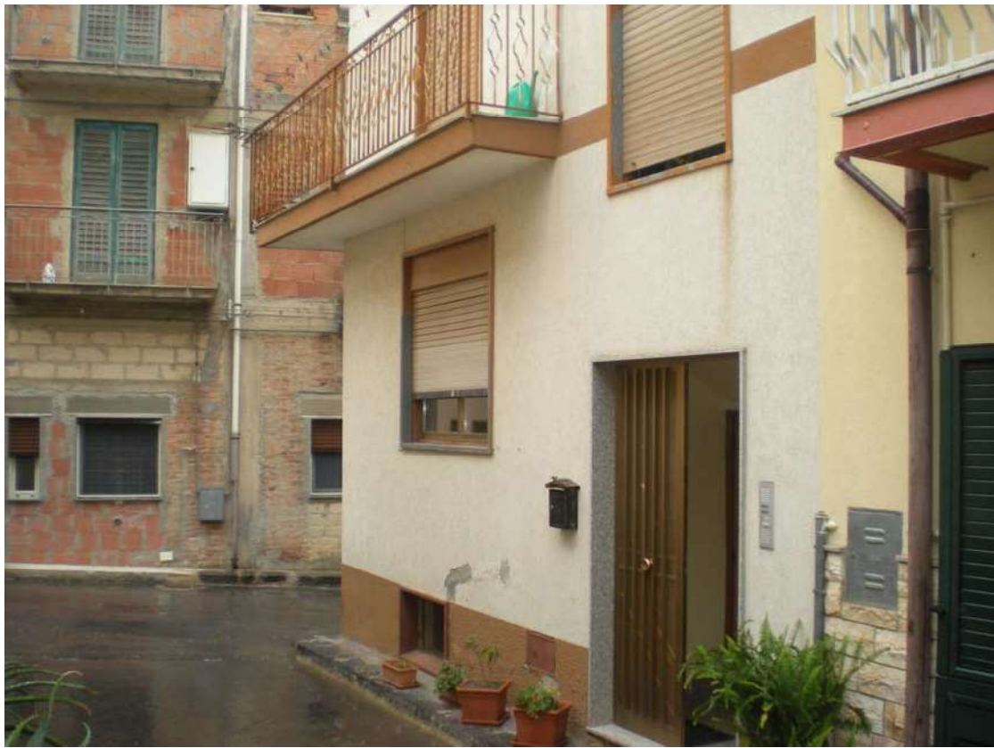
Foto 1: Ingresso principale immobile, Via Marasà n. 20
