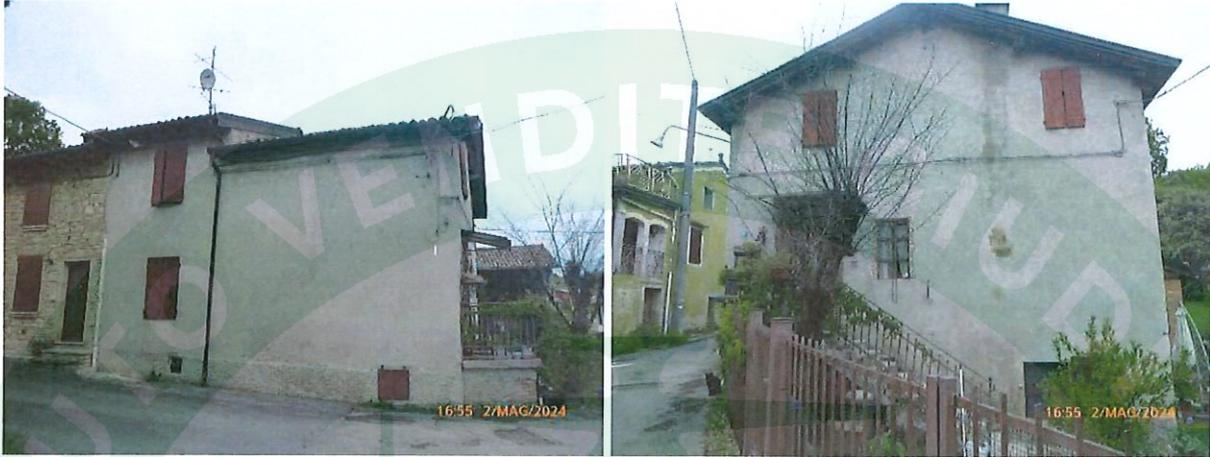
2. Murature perimetrali in elevazione del corpo secondario accessorio (Deposito – Ex Fienile) in muratura tradizionale mista di pietra e laterizio, solai in legno e Copertura in legno a due falde inclinate e manto di copertura in coppi;
