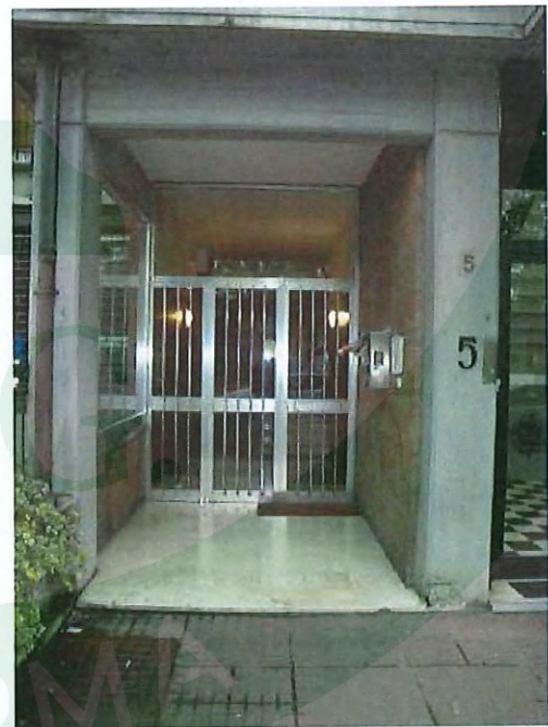
PARTICOLARE INGRESSO PEDONALE CIV. 5 DI PIAZZA CADUTI DEL LAVORO 9
