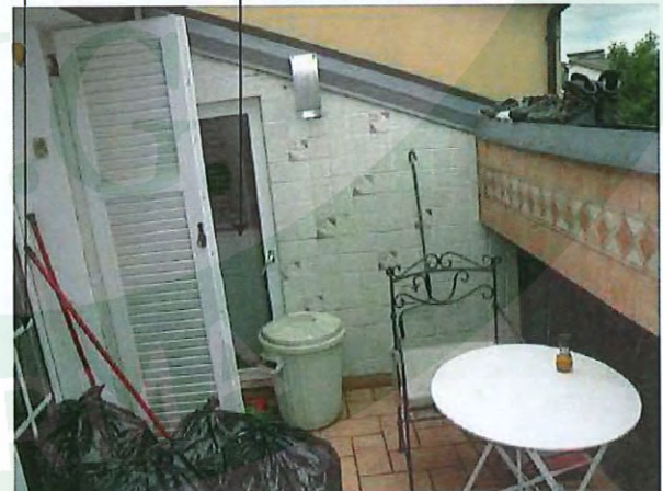
TERRAZZINO A TASCA LATO SUD
