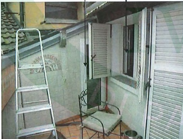
TERRAZZINO A TASCA LATO SUD
