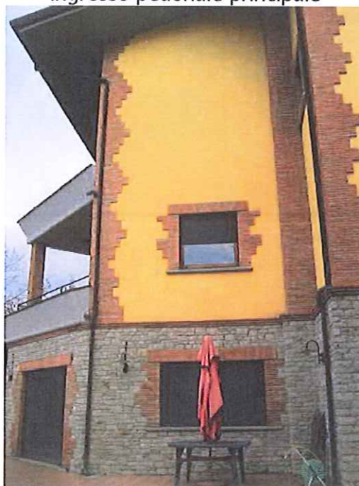
ingresso tavernetta piano seminterrato
