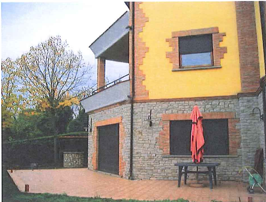
prospetto su lato posteriore (piano seminterrato e terra)
